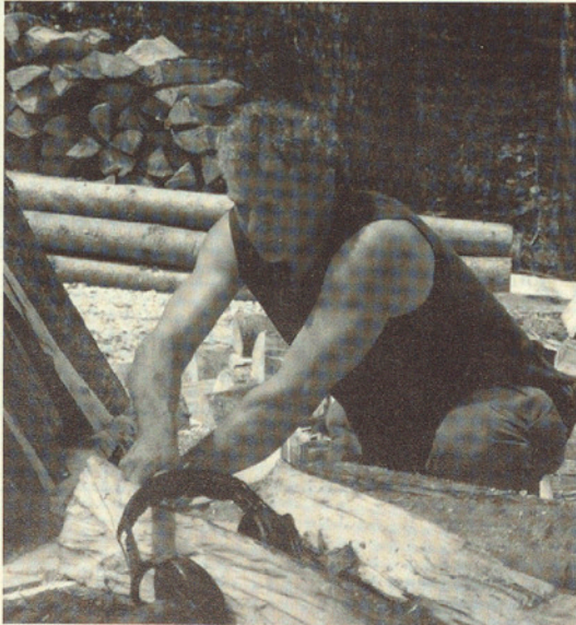
Die Rundhölzer am Boden lassen anfänglich noch etwas Luft zu.
