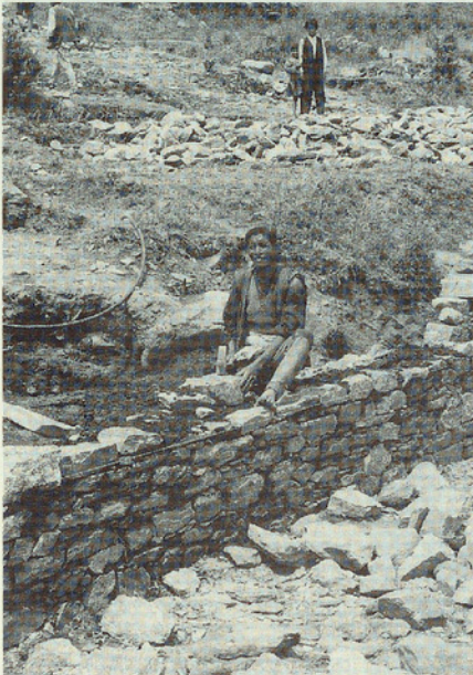
Stein für Stein: Oder ein lokaler Maurer auf der Klosterbaustelle.
