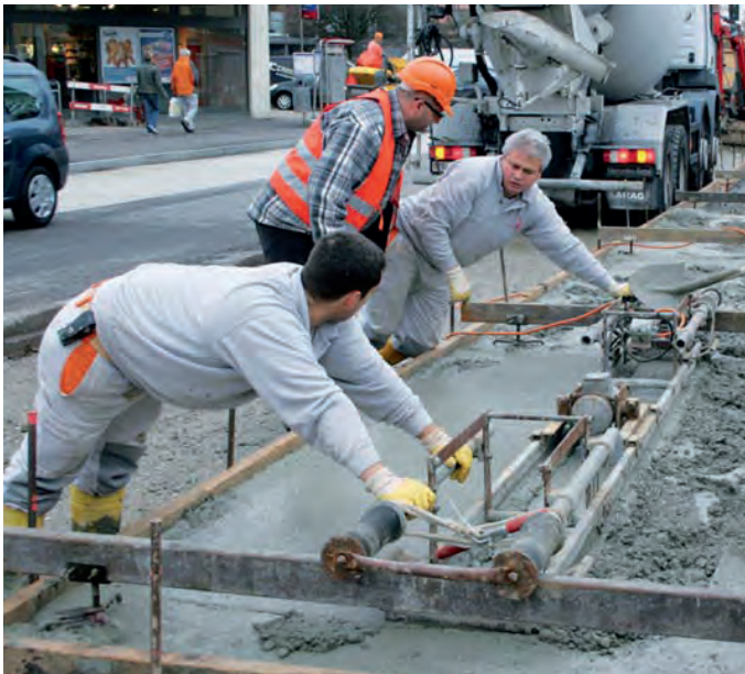
Tösstalstrasse: Einbau Betonplatte für die Bushaltestelle bei Garage Ruf
