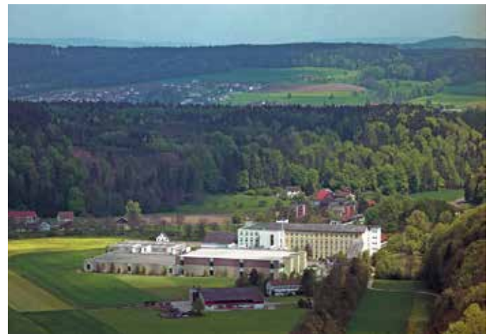
Die heutige Fabrikanlage als ehemalige Spinnerei wird jetzt eine neue Gewerbe- und Wohnfunktion erhalten.
