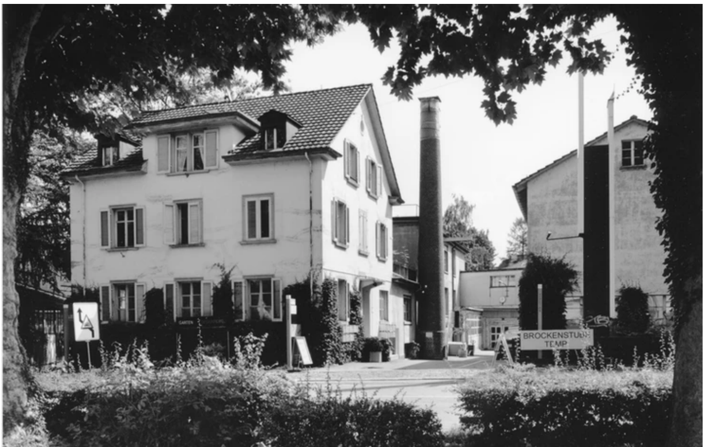
Fabrikareal Lienhard Söhne AG. 2005. Fotograf: Hanspeter Dudler. Baugeschichtliches Archiv Zürich.
