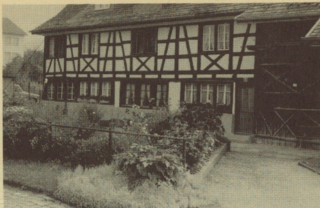
Flarz nach der Renovation.
