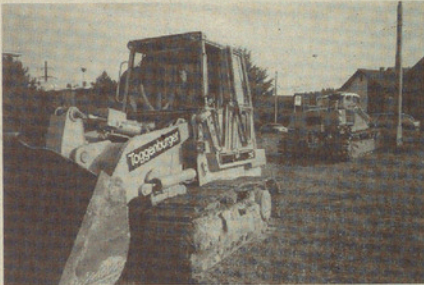
Die Baumaschinen fahren auf
