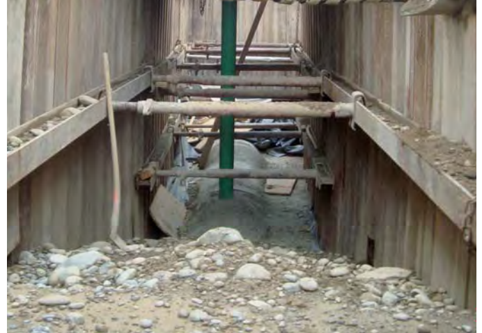
Ein Kanalgraben aus Arbeitersicht an der Kanzleistrasse
