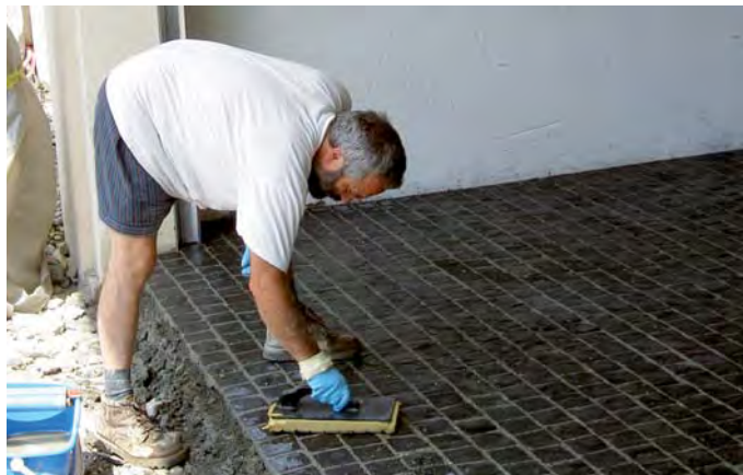
Nach dem Ausfugen reinigt Daniel Niederöst die Pflasterung
