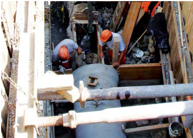
Arbeiten für den Kanalzusammenschluss an der Kanzleistrasse
