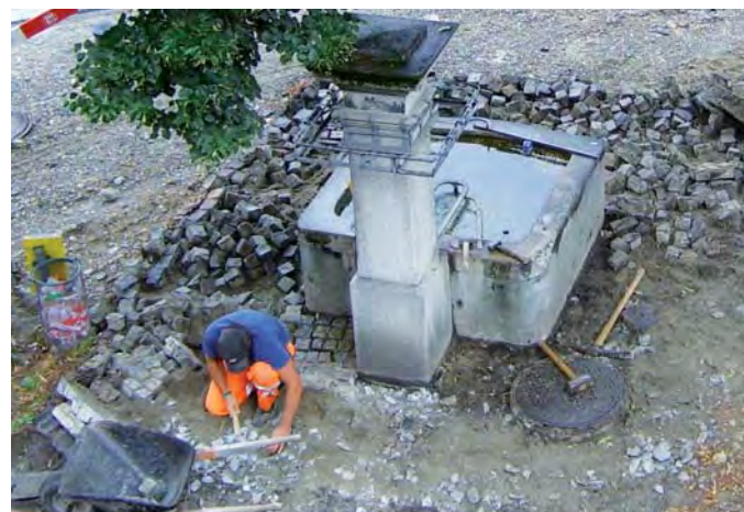
Pflasterarbeiten beim Brunnen Bollstrasse 2 (Sanierung der Tösstalstrasse)
