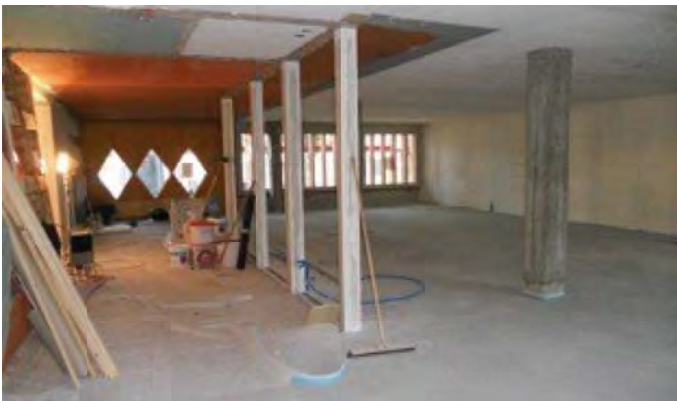
Noch ist die Bibliothek eine Baustelle
