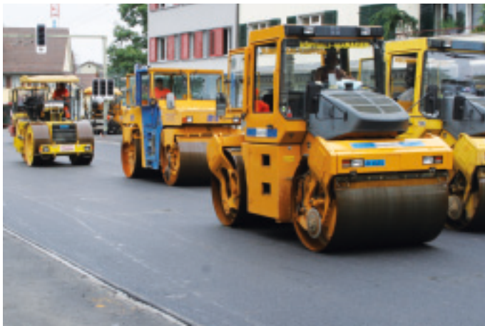
Deckbelagseinbau (Foto: Marc Dahinden)
