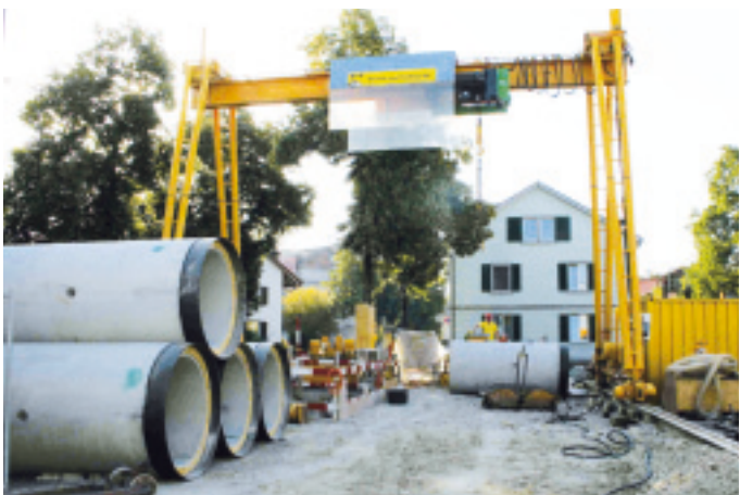
Der grosse Portalkran hebt die Betonrohre in die Grube
