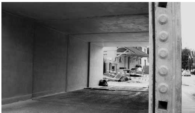
Einschub der neuen Fussgängerunterführung am Bahnhof Rikon (Foto: Hannes Gehring, IG Tösstallinie)
