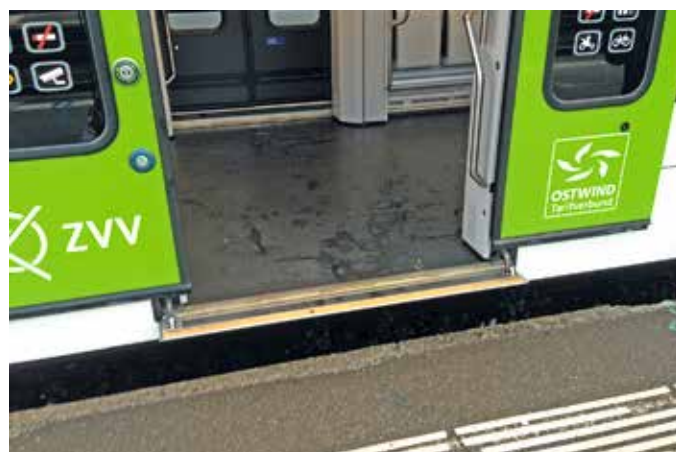
Grosser Spalt zwischen Tür der S26 und östliches Ende Bahnsteig Gleis 2 in Winterthur. Nach dem Umbau des Bahnhofs Winterthur gibt es stufenlosen Ein- und Ausstieg auf der ganzen Länge des Bahnsteig 2, Gleis 2. (Foto: Ralf Wiedenmann, IG Tösstallinie)
