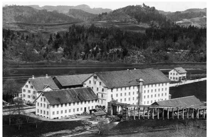
Bei der «Oberen Fabrik» in Kollbrunn, erstellt 1831, musste nach dem Hochwasser von 1876, die Zuleitung zum Kraftwerk mit einer Rohrleitung erneuert werden.
