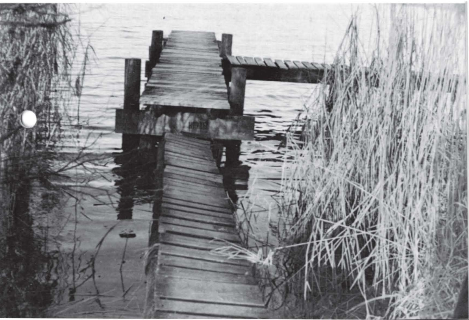
Im Gegensatz zu den soliden Fischerstegen an anderen Seen (z. B. Türlensee) sind diese am Pfäffikersee überaltert und müssen ersetzt werden.
