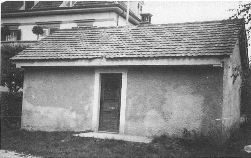
14. Gefängnis an der Oberen Reppischstrasse, zehn Jahre vor dem Abbruch 1961.
