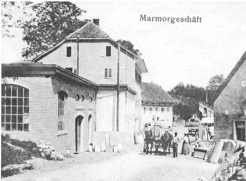
3. Aus der ehemaligen «Oberen Mühle» des Klosters Wettingen entstand 1895 das Marmorwerk der Firma Schmidt und Schmidweber, die «Marmor».
