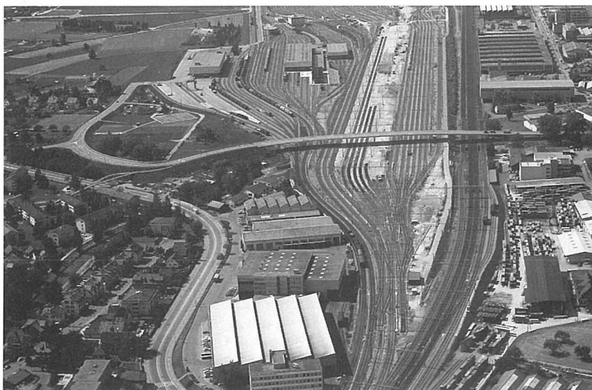
Rangierbahnhof Limmattal im Bauzustand 1978.
