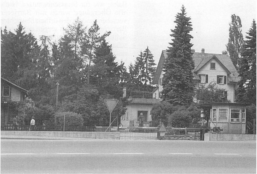
SBB-Übergang Zürcherstrasse 141 (Daubenmeier).
