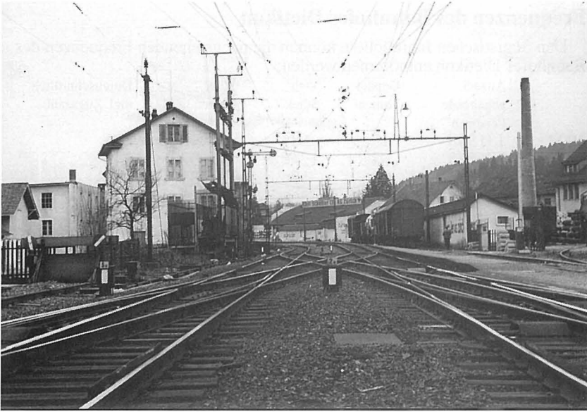
Ausfahrt Bahnhof Dietikon Doppelspur bis 1968. Links Areal Bollschweiler, rechts Areal Scheller.
