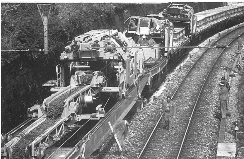
Heutiger Arbeitszug für Geleisetotalerneuerungen, mit Schichtleistungen von 80 bis 200 Meter.
