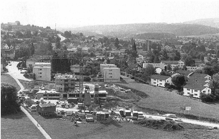
Abb. 11: Pflegerinnenschule FASRK im Bau
