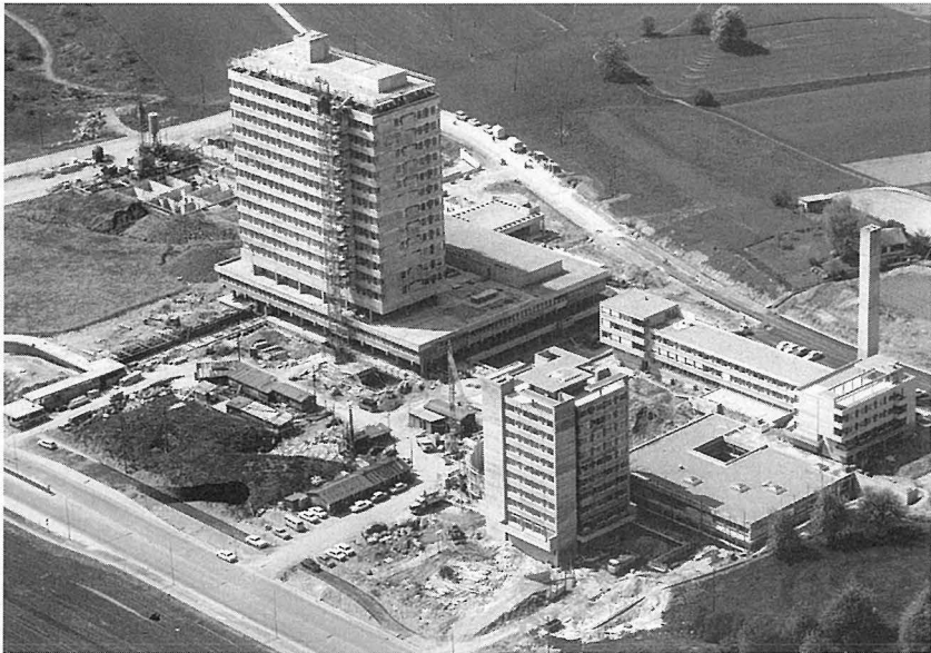
Abb. 9: Bauzustand bei der «Aufrichte»
