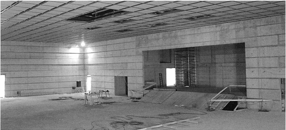
Ausbau in der grossen Halle
