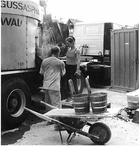
Die Bauarbeiten haben begonnen
