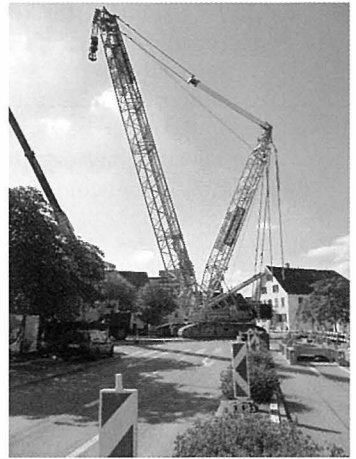
Ein 47m hoher Raupenkran bringt die neue Brücke an ihren Platz.
