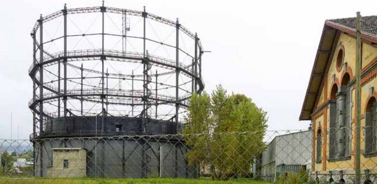
Oben: Bau der regionalen Erdgasleitung auf dem Herrenberg (links) und durch das Reppischtal, 1973. Unten: Heute steht der letzte Gasometer des Gaswerks Schlieren unter Schutz.
