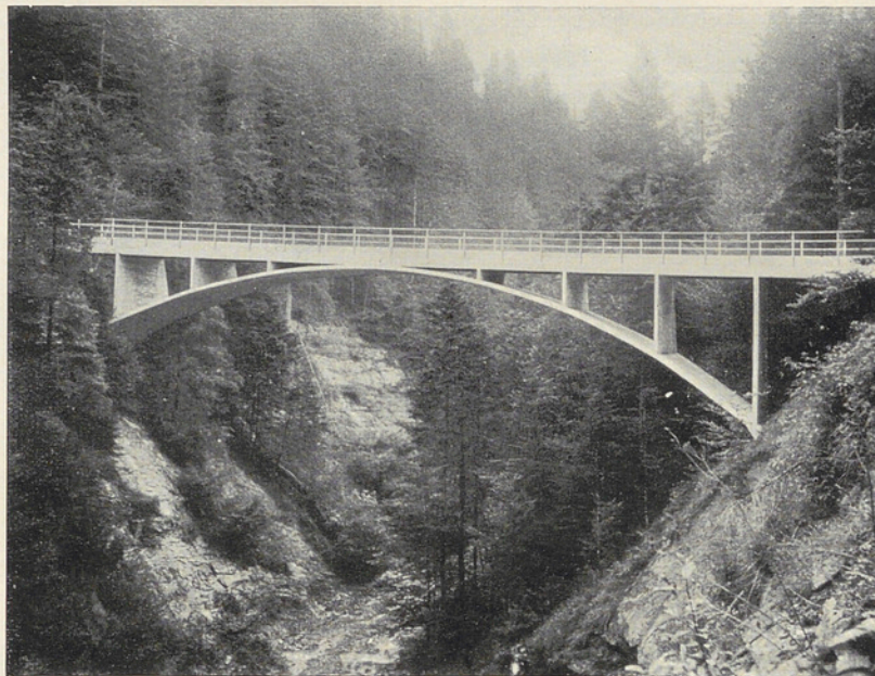
Abb. 54. Schwandbachbrücke Hinterfultigen-Schönentannen, Kt. Bern 1933. Versteifter, im Grundriss gekrümmter Stabbogen von 37,4 m Stützweite. Bauherr: Stassenbaugenossenschaft Hinterfultigen-Schönentannen. Unternehmung: Losinger & Co. A.-G., Bern, und Gebr. E. & A. Binggeli, Schwarzenburg.
