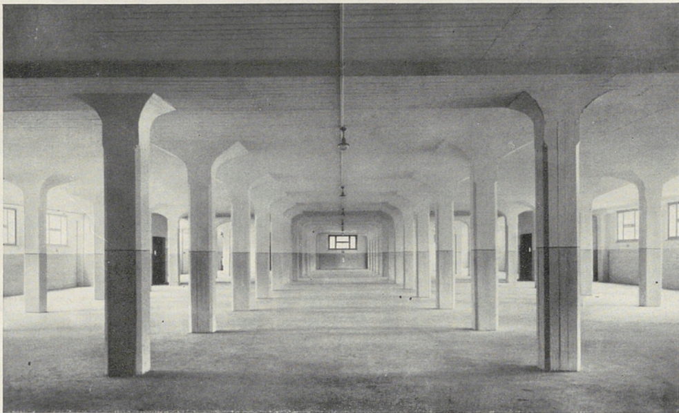
Abb. 21. Lagerhaus der S. A. Magazzini Generali, Chiasso 1924/25. Mittelgeschoss. Unternehmung: Bernasconi & Mascetti , Chiasso.
