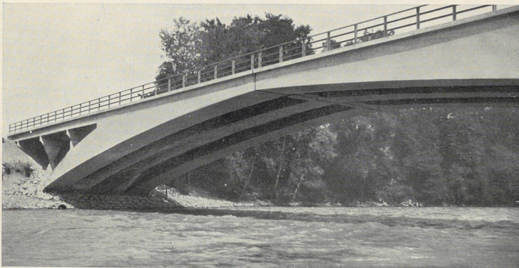
Abb. 37. Strassenbrücke über die Arve Champel-Vessy bei Genf 1937. Unterwasseransicht gegen das linke Arveufer.
