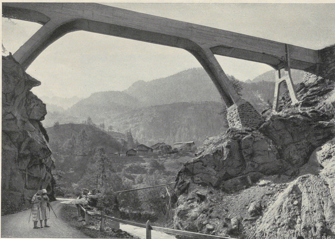
Abb. 55. Aquädukt über die Eau-Noire bei Châtelard für das Kraftwerk Vernayaz der SBB 1925. Ausführung: Prader & Cie., Ingenieure, Zürich.
