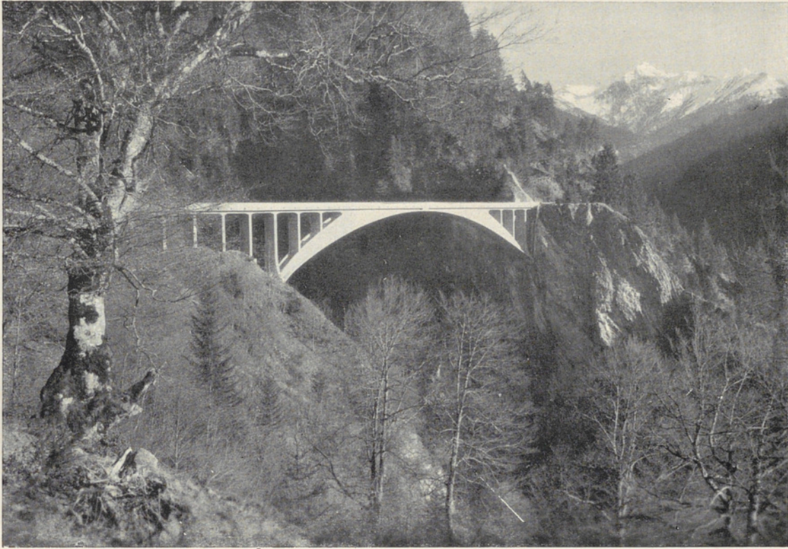
Abb. 28. Salginatobel-Brücke bei Schiers, Kt. Graubünden 1930. Dreigelenk-Kastengewölbe, Stützweite 90,04 m. Baudirektion des Kantons Graubünden: Oberingenieur J. Solca +. Unternehmung: Prader & Co. A.-G. , Ingenieure und Bauunternehmer, Zürich-Chur. Gerüst-Projekt und Ausführung: R. Coray , Chur.
