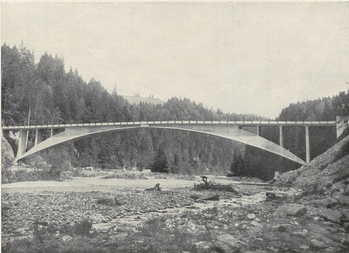
Abb. 32. Rossgrabenbrücke über das Schwarzwasser, Gemeinde Schwarzenburg, Kt. Bern 1932. Dreigelenk-Kastengewölbe. Stützweite 82,00 m. Bauherr: Gemeinde Wahlern und Weggemeinde Hinterfultigen . Unternehmung: Losinger & Cie. A.-G. , Bern, und Gebr. E. & A. Binggeli , Schwarzenburg.
