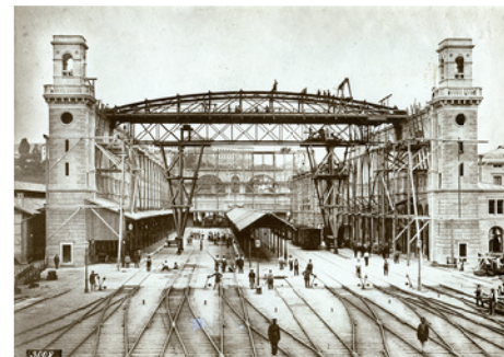
Der neue Hauptbahnhof im Bau 1867 (Foto: BAZ_098164)
