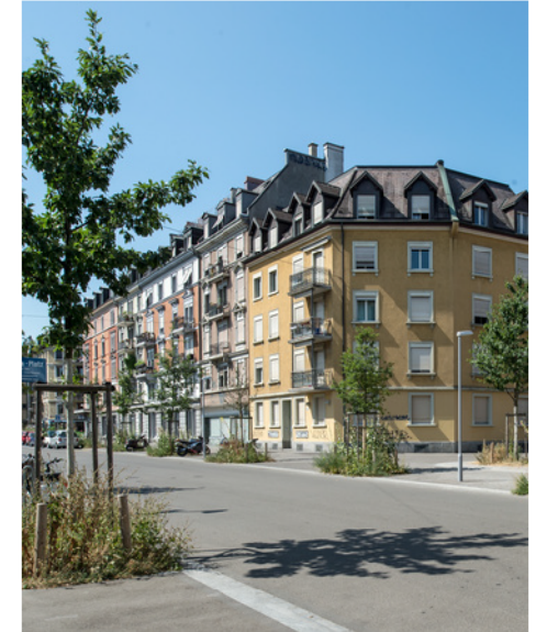
Seit 2010 von Verkehr befreit: Die Sihlfeldstrasse (Bild: BAZ_030569, Tom Hussele)
