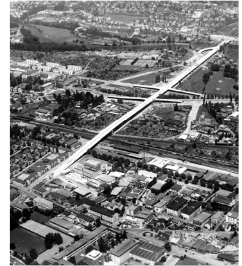
1963: Die Europabrücke wird dem Verkehr übergeben (Bild: BAZ_059043, Swissair)
