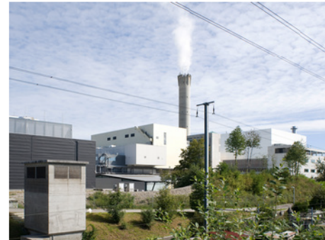
Seit 1969 im Quartier: Das Kehrichtheizkraftwerk Hagenholz (Bild: HAL_009808, Juliet Haller)
