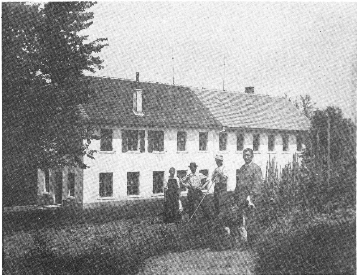
Abb. 1 Fabrikgebäude der Firma Güller in Hüttikon nach der ersten Vergrößerung von 1897. Das Bild beweist, dass um die Jahrhundertwende auch in Hüttikon noch Weinreben angebaut wurden.
