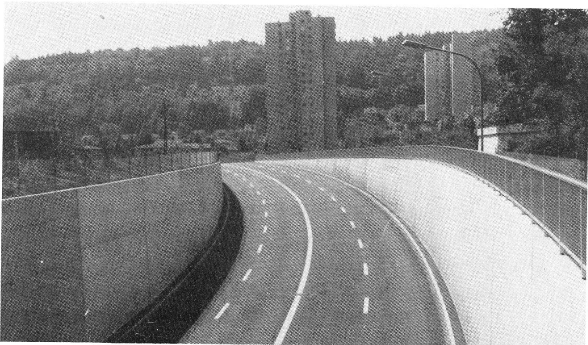
Abb. 8 Der im Dezember 1977 dem Verkehr übergebene «Ostring»: Östliche Umfahrungsstrasse des Zentrums Regensburg mit Untertunnelung des SBB-Areals. Im Hintergrund die dominierenden, 1971 – 1974 erbauten Hochhäuser.
