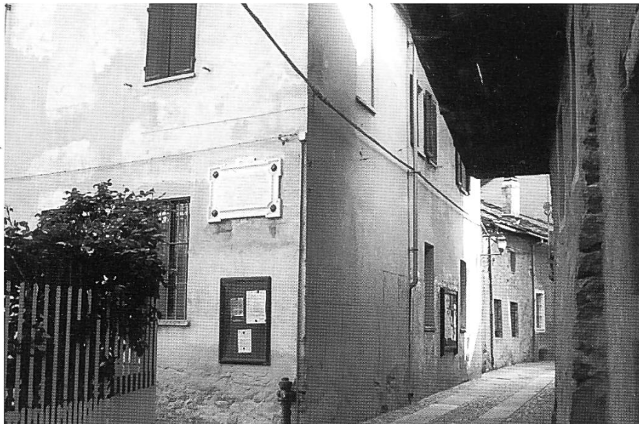
Das alte Gemeindehaus heute. Im Raum hinter der Erinnerungstafel befand sich der Kindergarten, darüber die Gemeindeverwaltung (Foto Mädi Thommen)
