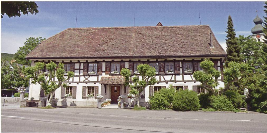
Gasthof Rössli an der ehemaligen Furt, heute Bachbrücke (Gemeinde Würenlos)
