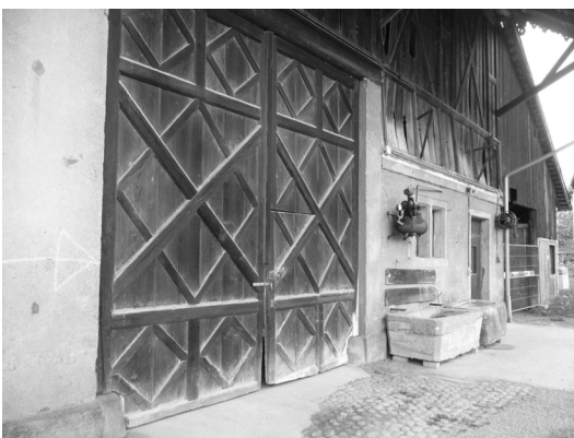
„Zentrumsschür“ aus hiesigen Baustoffen
