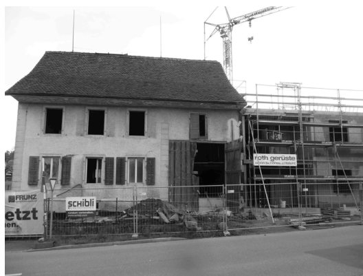
Zweckdienliche Lösung: Teilabbruch
