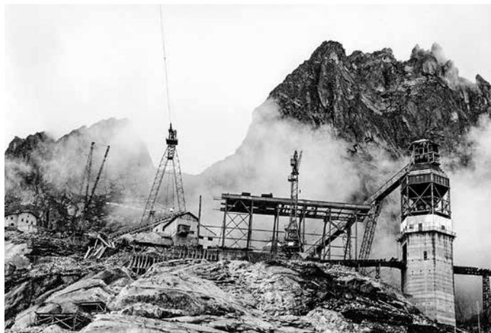
[Bild 22] Betonaufbereitungsanlage mit Betonturm, 1957
