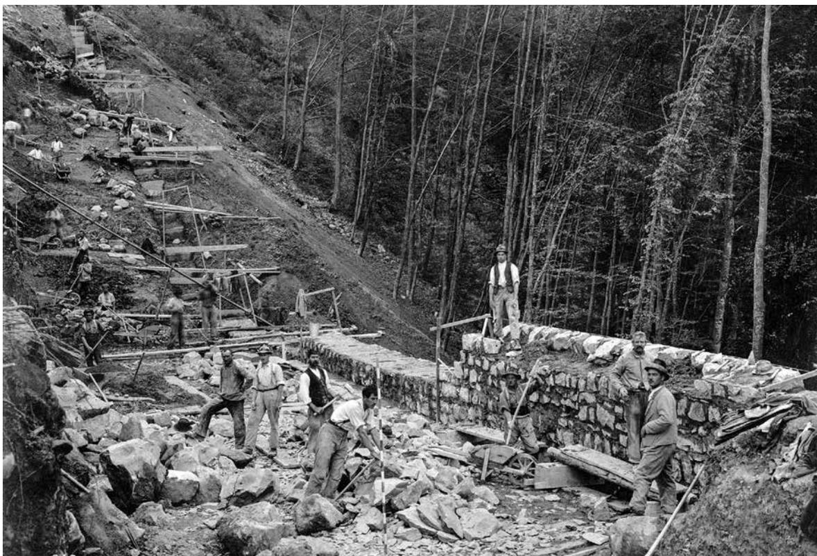
[Bild 13] Bauarbeiten am Druckstollen, 1923
