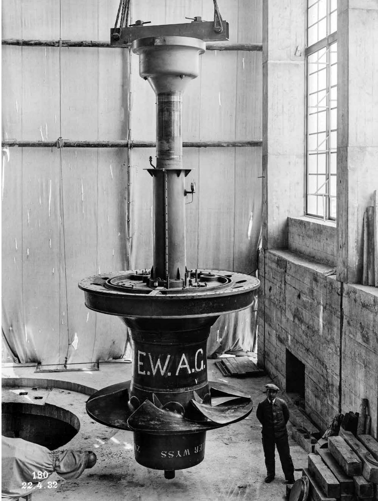
[Bild 11] Kraftwerk Wetztingen, Maschinensaal, Montage Turbinenlaufrad (Kaplan, Escher Wyss), 1932
