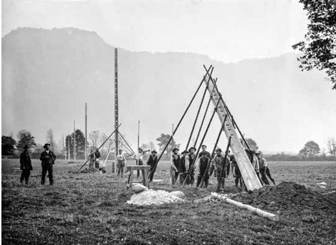
[Bild 11] Fernleitung Sils-Zürich, Aufrichten eines Betonmasts, 1909
