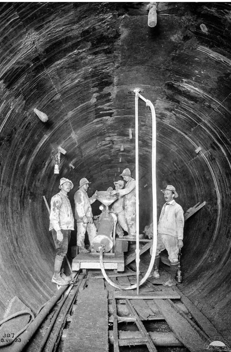
[Bild 11] Zementinjektion am Druckstollen, 1923
