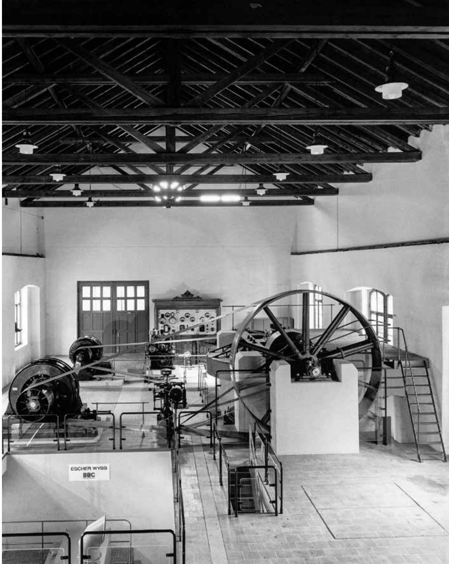
**[Bild 12]** Kraftwerk Höngg, Kraftwerk am Giessen, Maschinenhalle mit Straflo-Turbine (Sulzer-Escher Wyss, BBC, 1983, vorne versenkt), Jonval-Turbine (Rieter, 1898, Mitte) und Francis-Turbine (Escher Wyss, 1917, hinten). An der Rückwand Schalttafel für die beiden alten Maschinen, 1981
