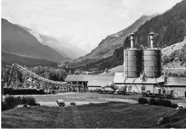
[Bild 7] Talstation Pranzaira mit Zementumschlagplatz und Zementseilbahn und Silos
