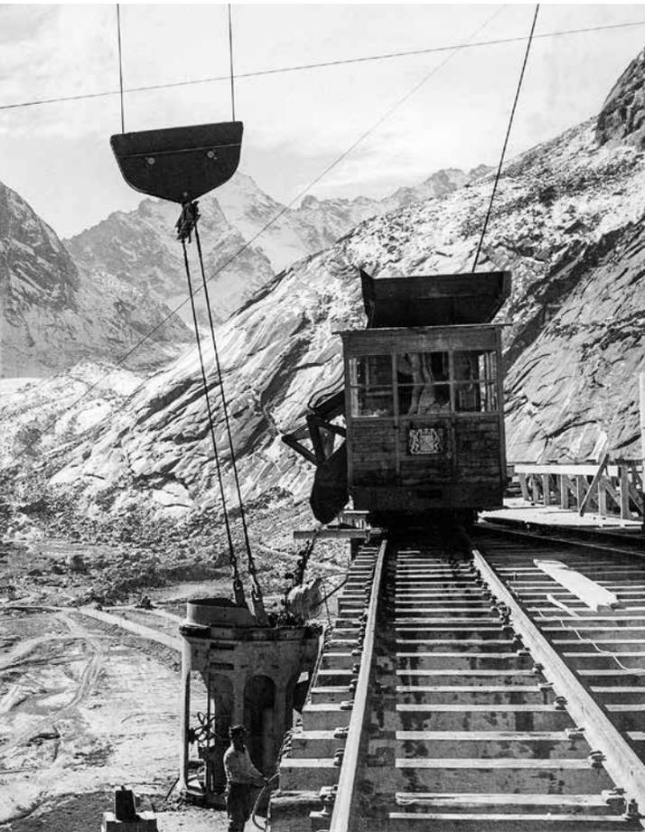
[Bild 26] Staumauer Albigna, für den Betontransport umgebautes Tram der Zürcher Verkehrsbetriebe, 1957
