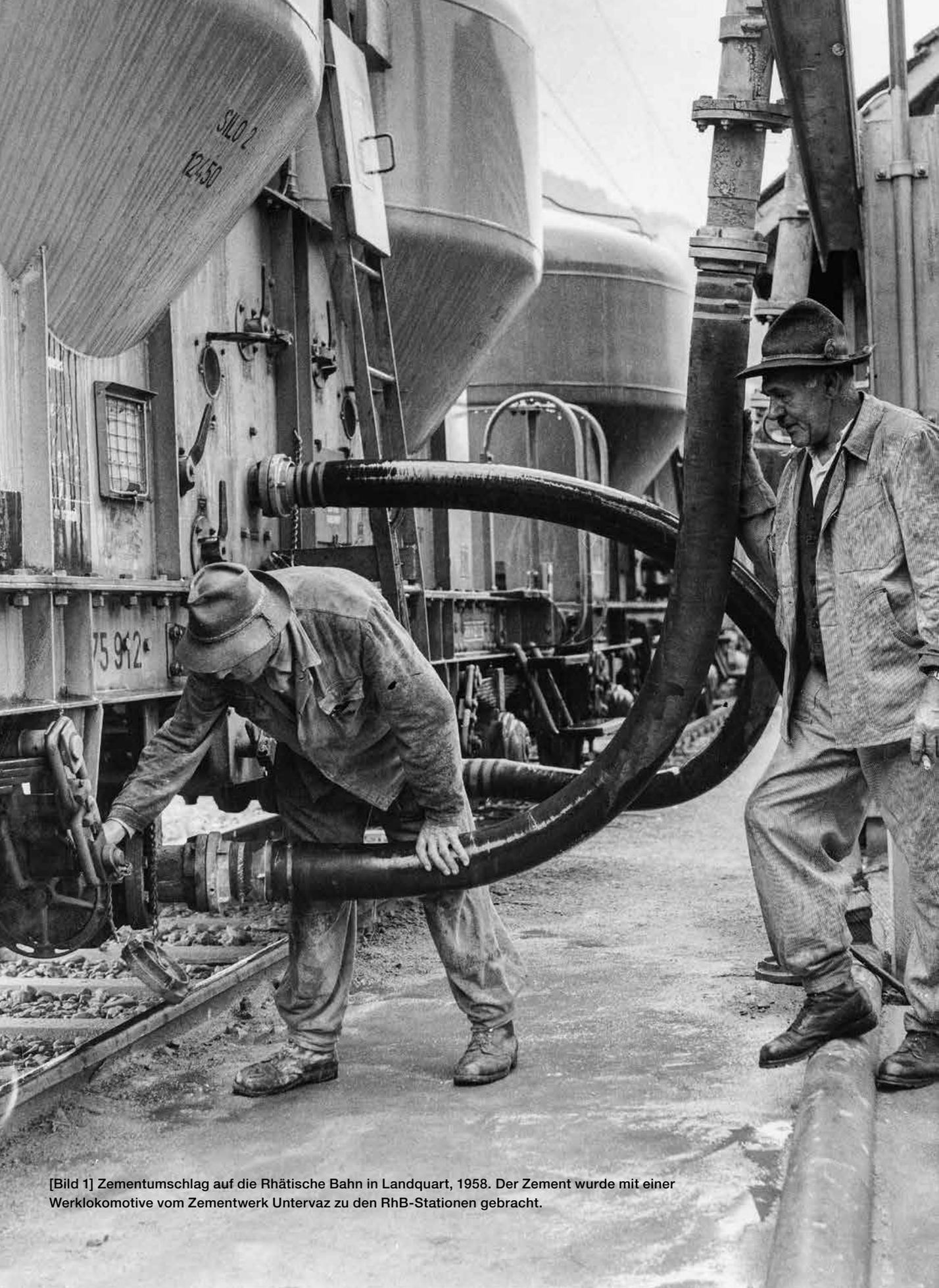
[Bild 1] Zementumschlag auf die Rhätische Bahn in Landquart, 1958. Der Zement wurde mit einer Werklokomotive vom Zementwerk Untervaz zu den RhB-Stationen gebracht.
