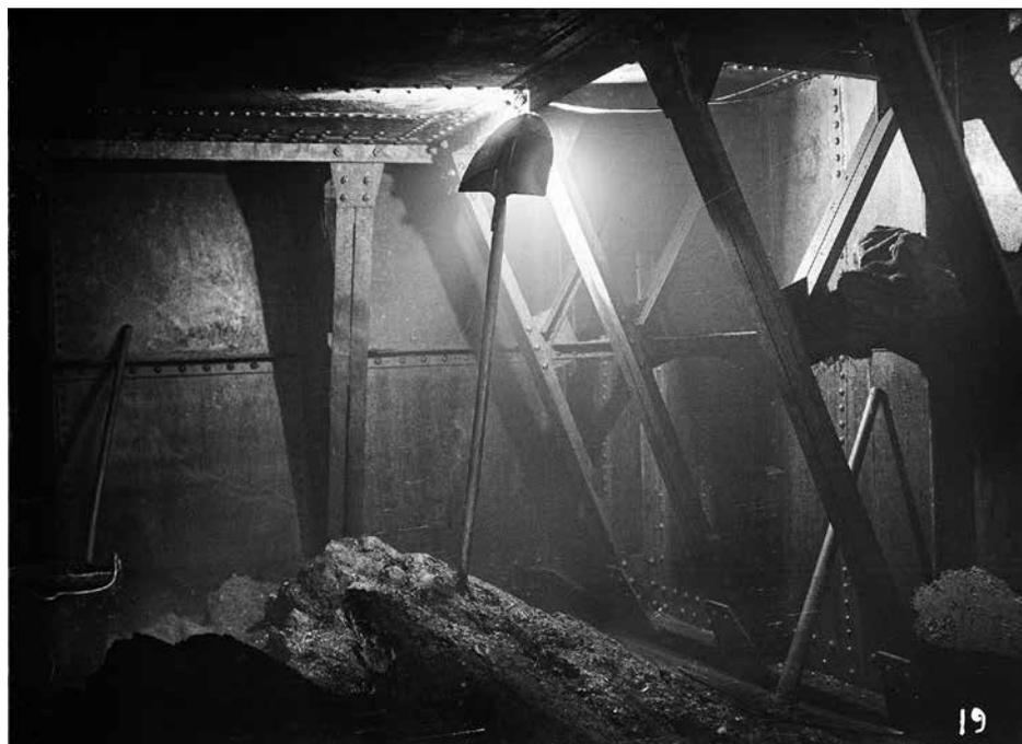
**[Bild 8]** Bau Wehr Nisellas: Aushubarbeiten in einem der eisernen Caissons, 1908
