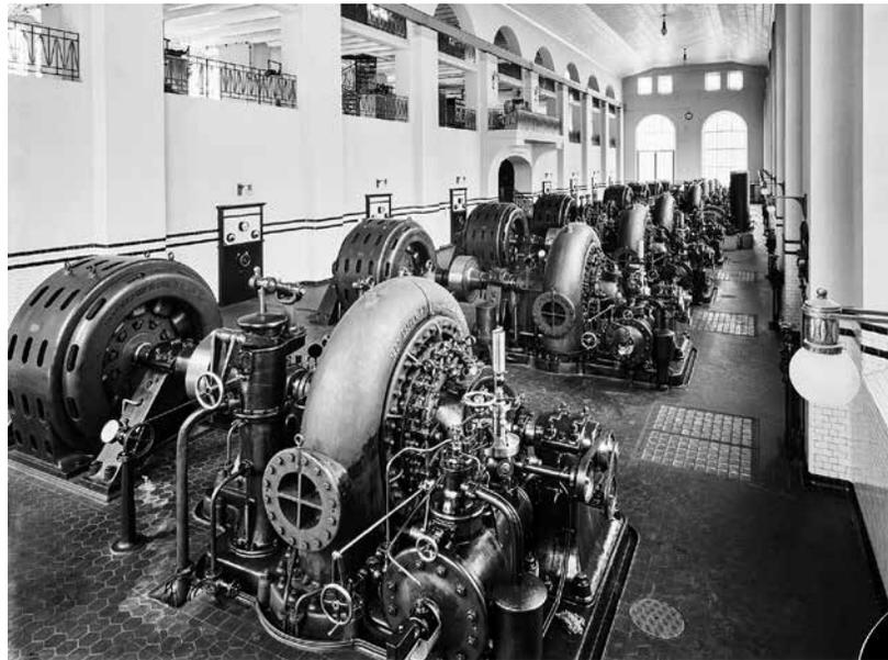
[Bild 17] Maschinensaal Zentrale Sils, 8 Francis-Turbinen der Escher Wyss und 8 Generatoren, 1911
