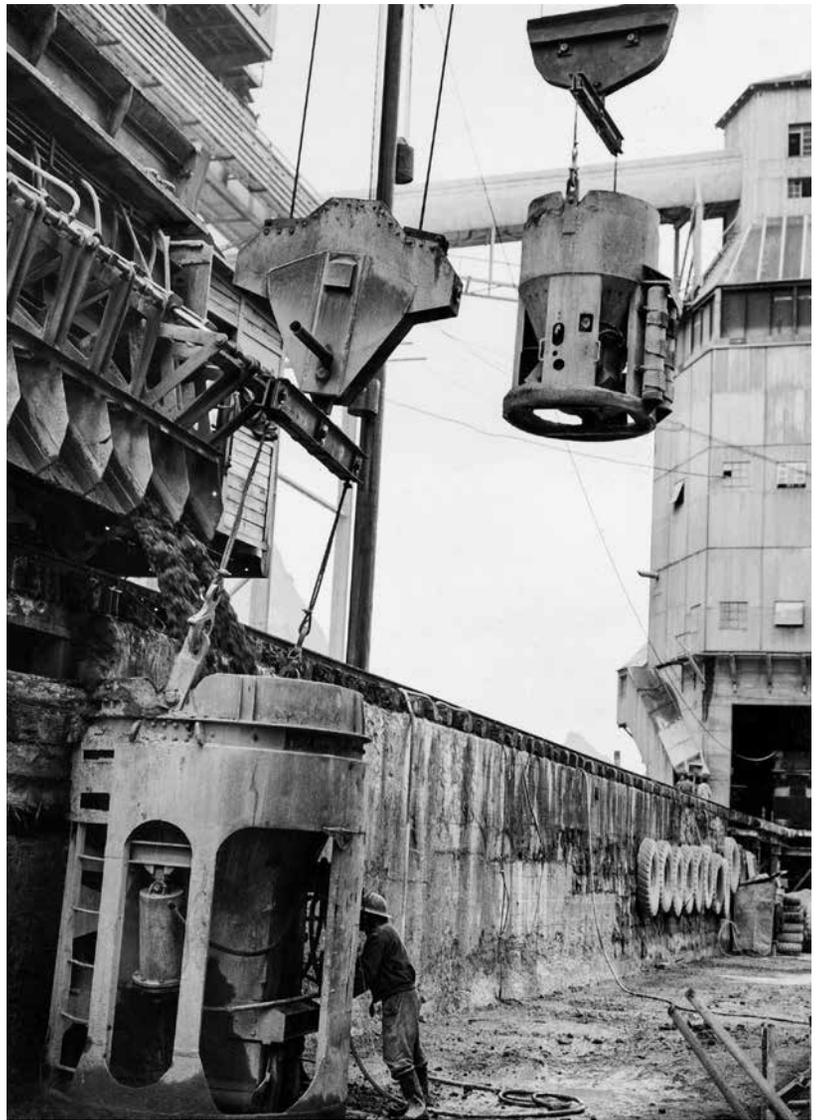
[Bild 24] Staumauer Albigna, Betonturm und Betonkübel, 1959
