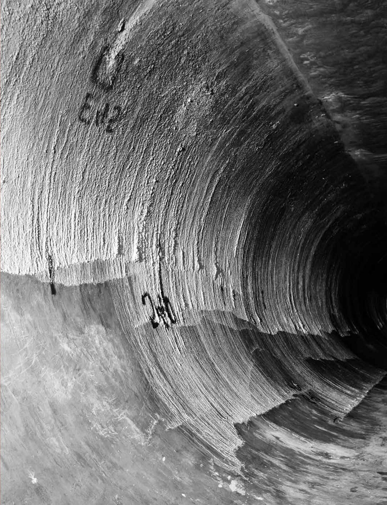
[Bild 10, links] Kraftwerk Tiefencastel West, Juliawerk Tiefencastel, Druckleitung, Risse und Ausscheidungen im fertigen Stollen (bei Markierung 540), 1948
