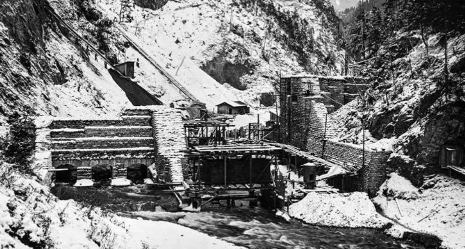
**[Bild 7]** Kraftwerk Sils, Albulawerk Sils, Wehr Nisellas, Aufhängung und Gerüste für die eisernen Caissons, 1908
