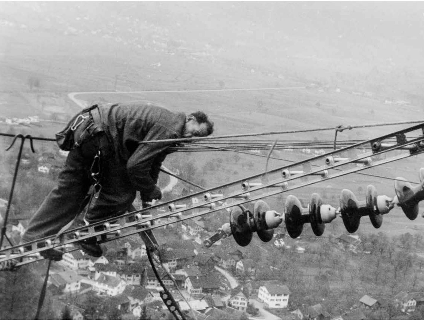
[Bild 16] Montage von 150-kV-Abspannkettens und Stromschlaufen, 1950
