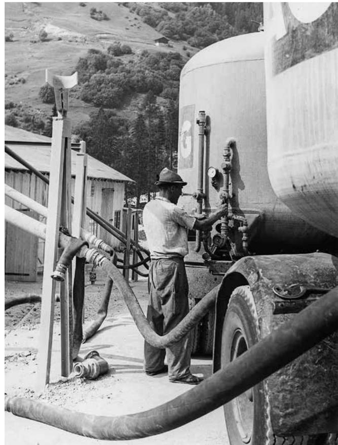
[Bild 9] Zementumschlag vom Lastwagen in die Silos in Pranzaira, 1958
