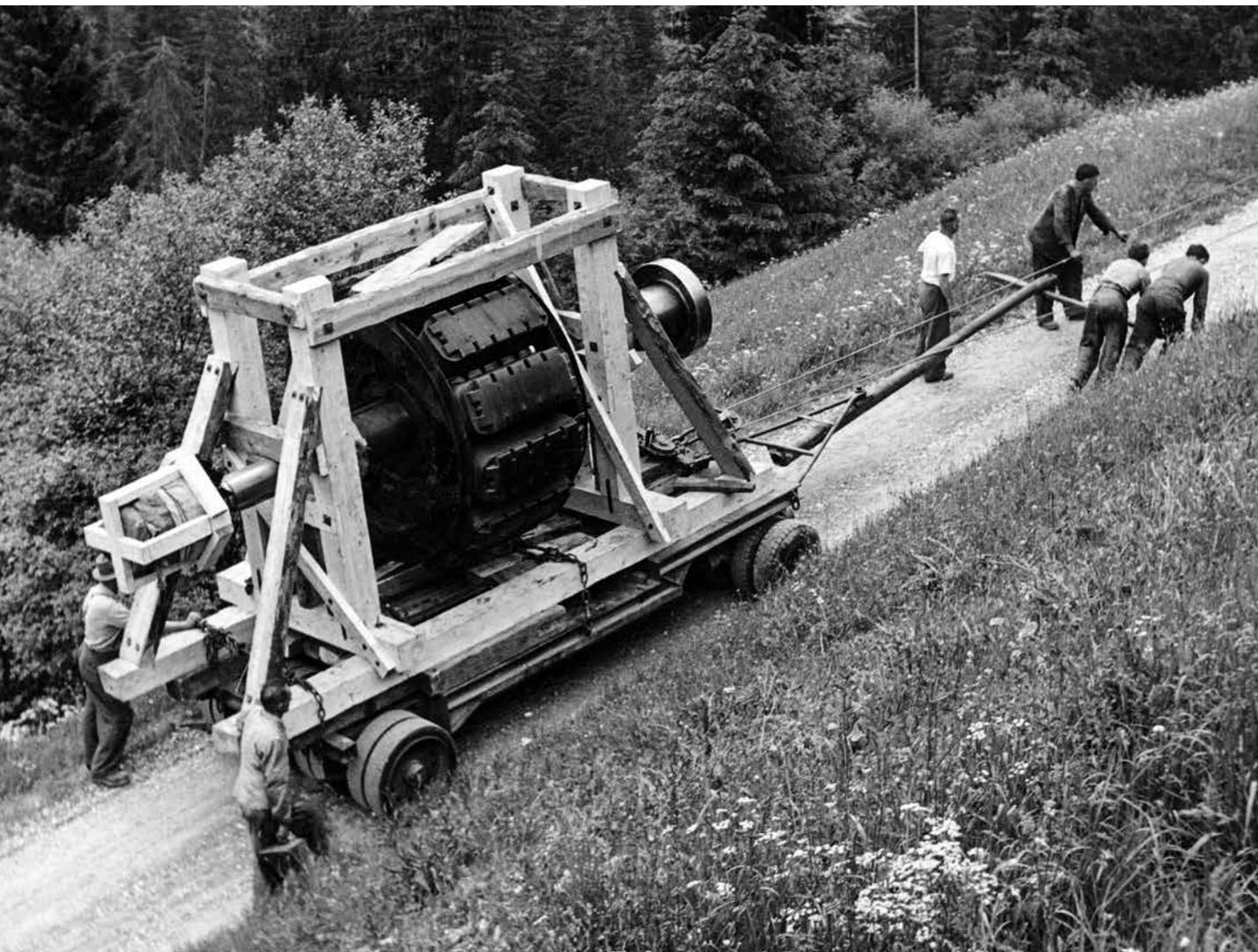
[Bild 53] Solis, Heidseewerk, Umbau der elektromechanischen Anlagen, Transport des Generator-Rotors vom Maschinenhaus zum Bahnhof Solis zwecks Umbau bei der Maschinenfabrik Oerlikon (MFO), 1951
