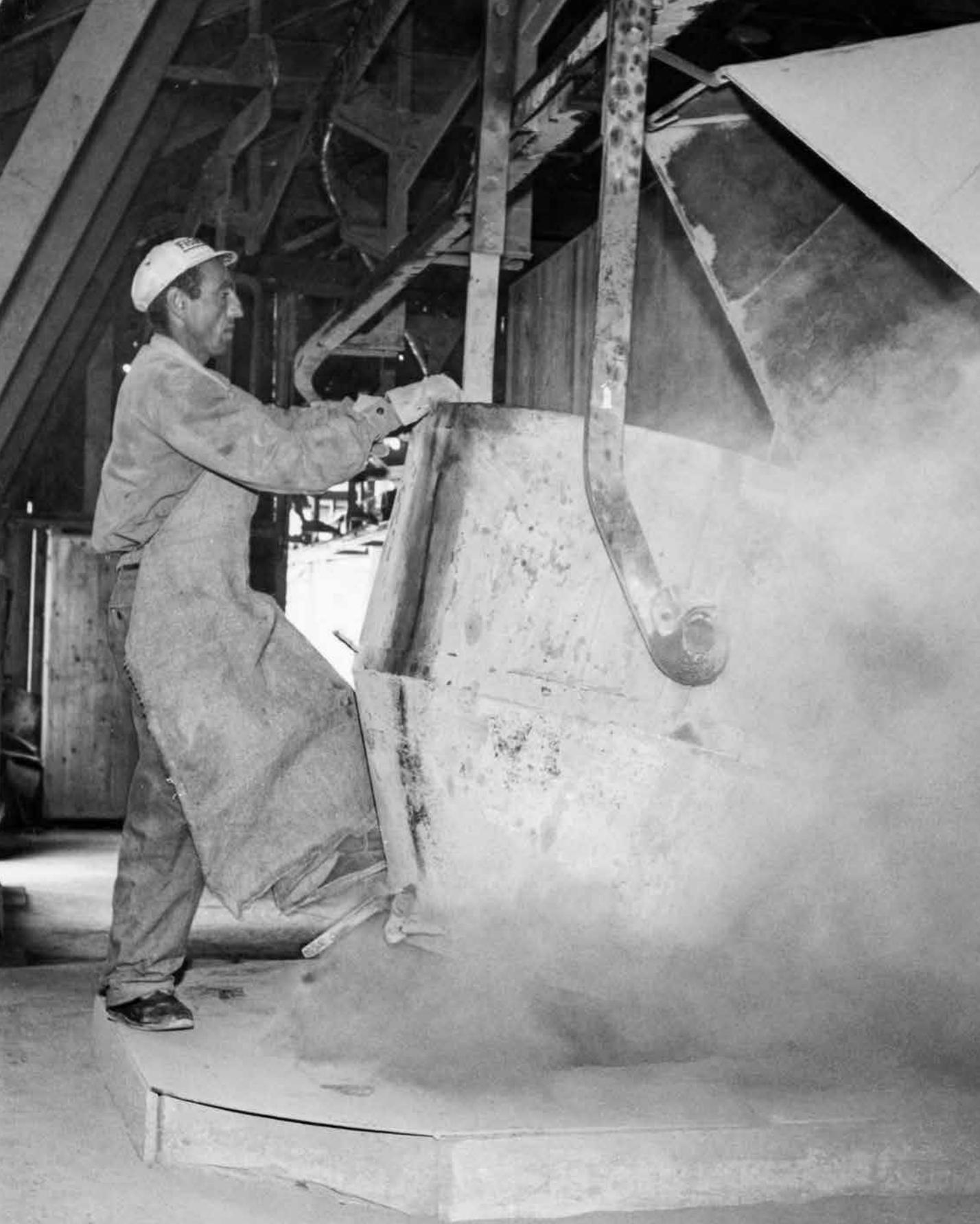
[Bild 14] Entleeren der Zementkübel auf Albigna, 1958
