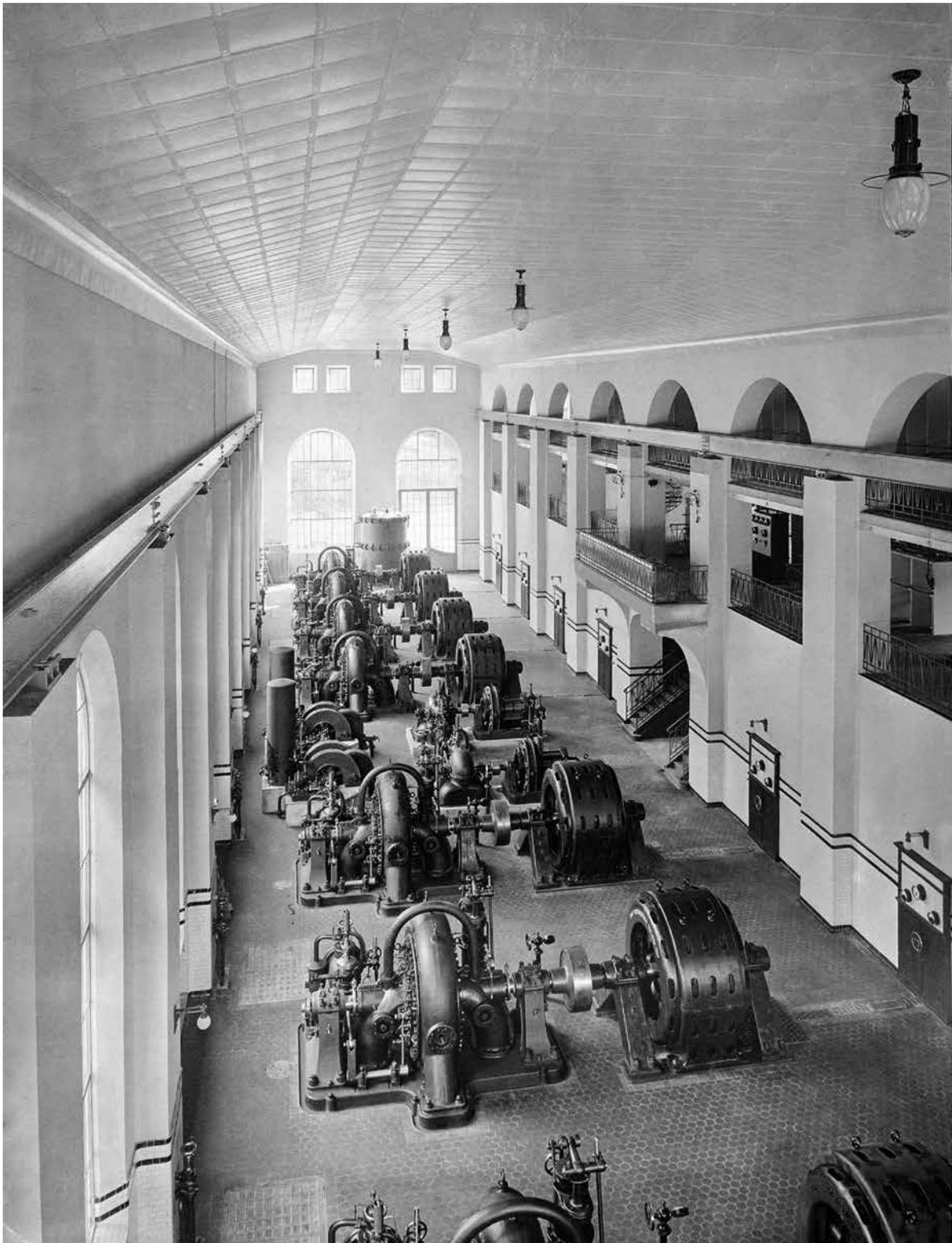
[Bild 2] Albulawerk Sils, Maschinensaal. Links die Francisturbinen, welche die Energie des Wassers auf die Generatoren führen (rechts im Bild)
