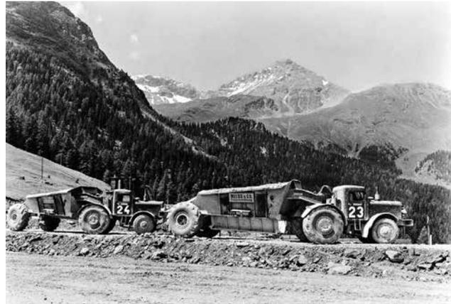
[Bild 32] Der eindrückliche Maschinenpark an der Baustelle Marmorera: Euklid-Kipper, 1952
