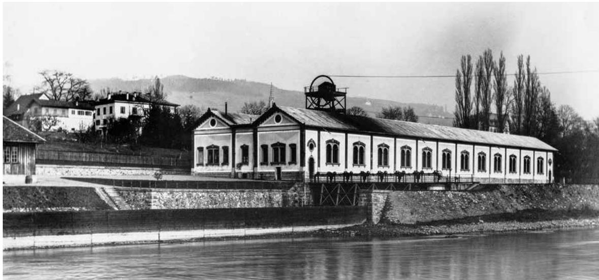
[Bild 4] Kraft- und Wasserwerk Letten. Ansicht des Turbinen- und Pumpenhauses mit Transmission über die Limmat, 1892
