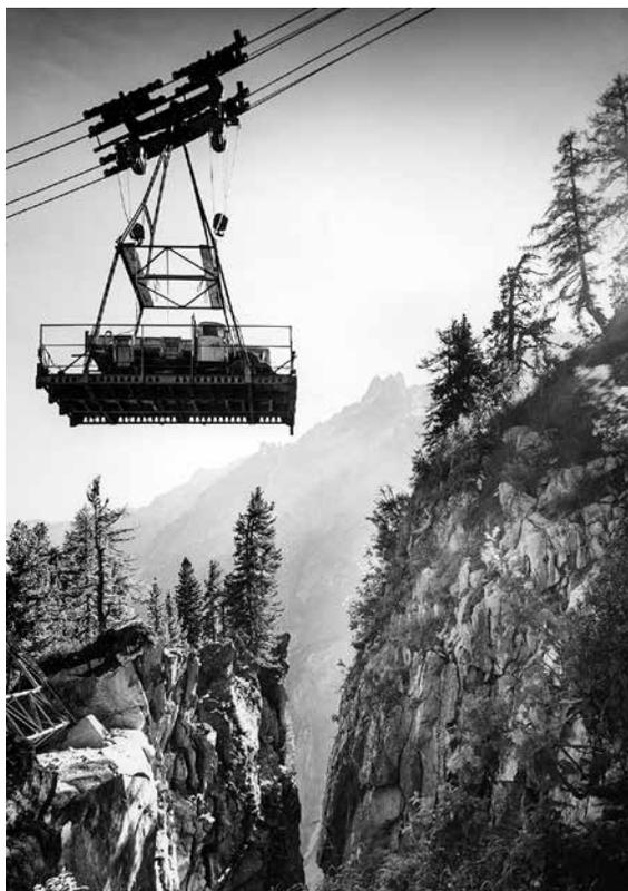
[Bild 46] 6-Tonnen-Schwerseilbahn
