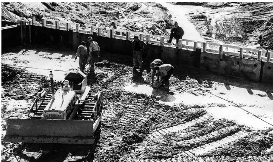
[Bild 35] Verteilen des Betons mit Bulldozer, 1957
