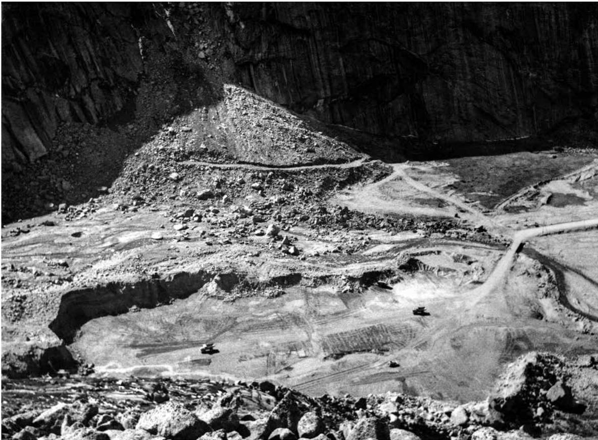
[Bild 15] Talboden Albigna, 1955. Der Talboden wurde ausgebagert und als Materiallieferant für Betonkomponenten benutzt.
