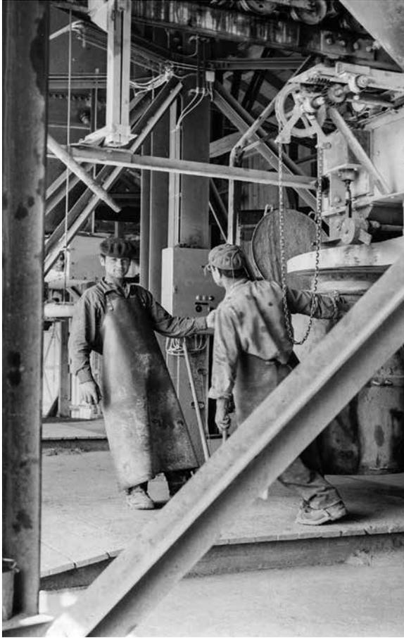
**[Bild 10]** Füllen der Seilbahnkübel mit Zement
