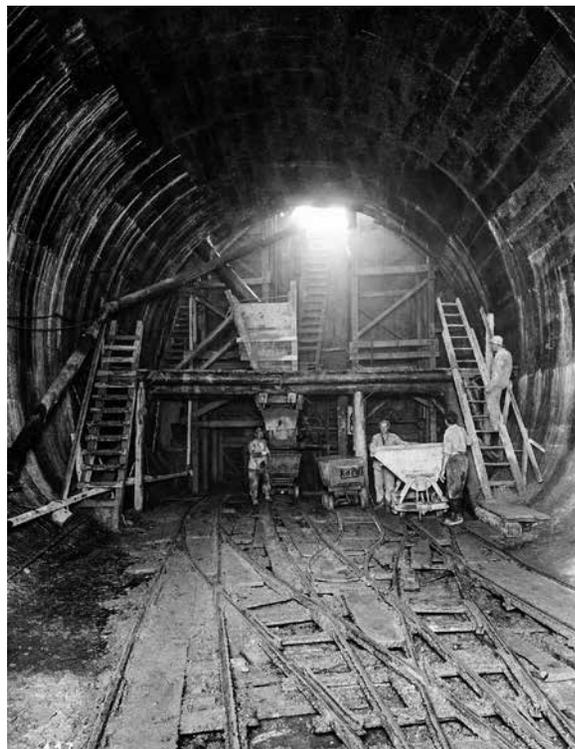
**[Bild 18]** Bau des Druckstollens Wetztingen, 1931
