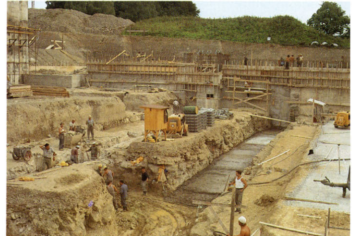
Abb. 6 Baugrube des Sanitas-Spitals im September 1970. Blick gegen die Süd- wand der Baugrube. Im Vordergrund in der Baugrube gelbgraue Mergel- und Mergelsandsteine der Oberen Süßwassermolasse. An der Süd- wand über der Betonmauer ist typische Moräne zu erkennen, welche die Molasse überdeckt. Die Moräne ist ungeschichtet mit unregelmäßig eingelagerten Blöcken. Im Hintergrund sind die Bäume des Chilewäld- lis zu erkennen. (Fotos F. Pavoni-Lezzi)
