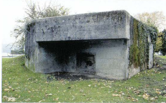
Vier Aufnahmen des Lmg-Standes A 4825 in der Schilfmatt. Er verkörpert den typischen Leichtstand, wie er überall im Bereich des Stadtkommandos gebaut wurde.
