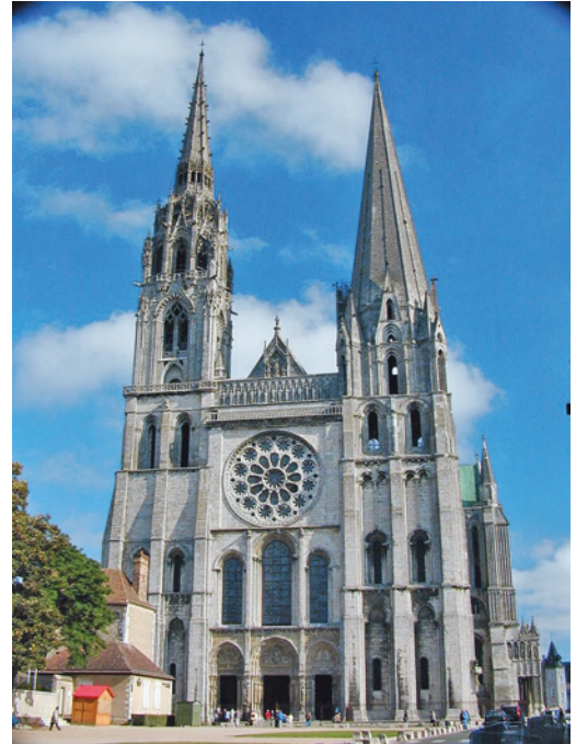
21 Westfassade der Kathedrale.
