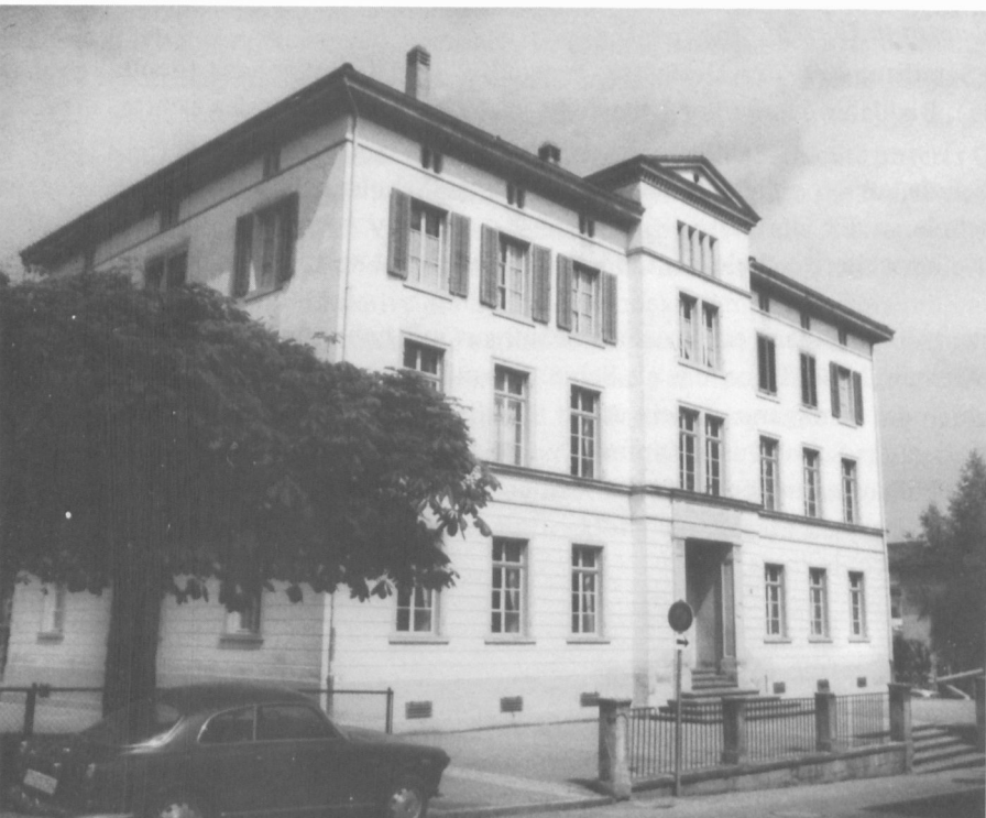
Schulhaus Baumgärtli, eingeweiht 1854, welches gegenwärtig einer umfassenden Renovation unterzogen wird.
