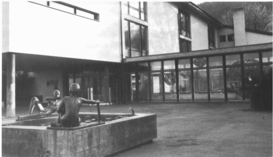
Pausenplatz des 1959 bezogenen Schulhauses Tannenbach.
