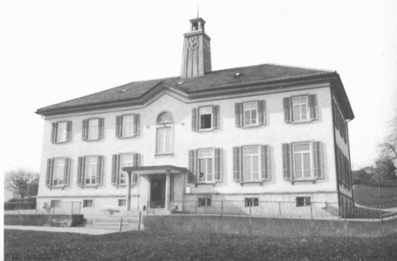
Schulhaus Wührenbach im Horgenberg, erbaut 1898, 1922/23 erweitert.
