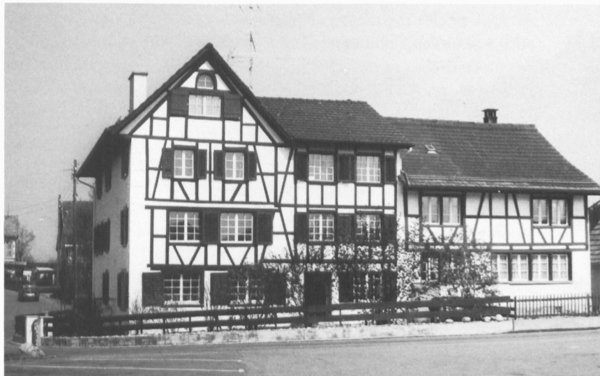
Die renovierten Häuser im Wührenbach (Aufnahme 1978)
