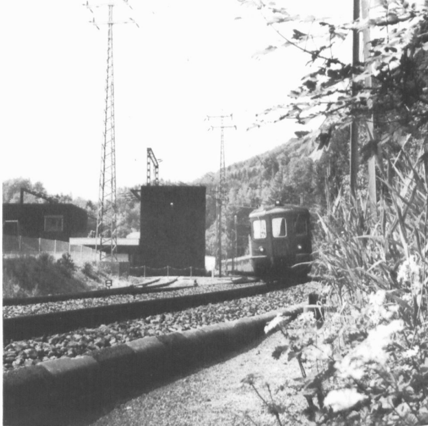
Die Neubauten des Unterwerks in der Sparrenau
