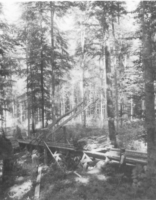
Seilbahn für den Brennholztransport, Kippe zum Ausweichen der Schlitten (Aufnahme 1912)
