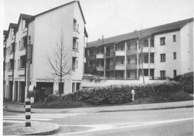
Von 1983 bis 1986 baute hier die Gemeinde das Seniorenzentrum «Baumgärtlihof».
