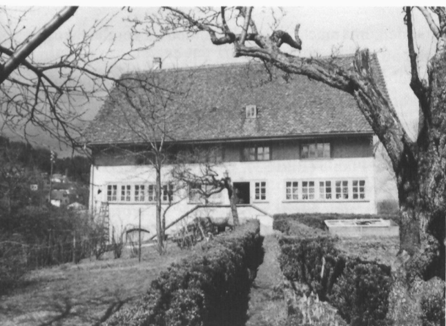
47 Das Bauernhaus im Heubach war ein typisches Zürichsee-Giebelhaus mit Reihenfenstern.
