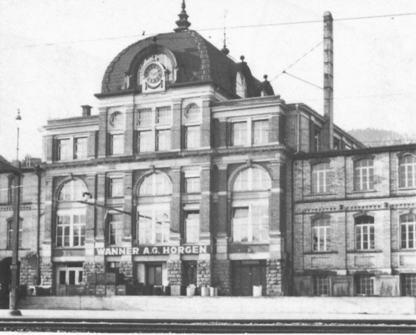
Die Kuppel der ehemaligen Wannerschen Fabrik von der Seegartenstrasse her gesehen.
