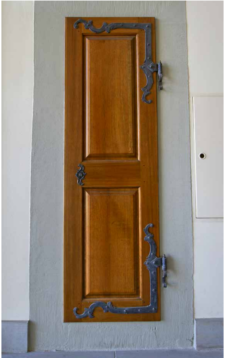
Eingang zum Kirchturm der reformierten Kirche Horgen, 2019.
