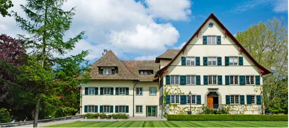
Landhaus Bocken mit dem Seitenflügelanbau von 1913, 2019.
