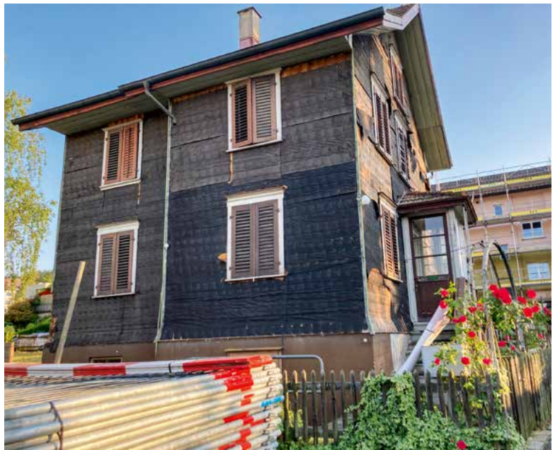
Ehemals Katzenstrasse 3 (2023 abgebrochen), 2023.
