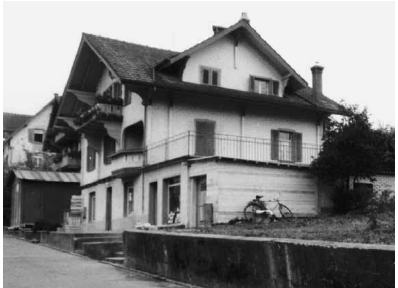
Ehemals Glärnischstrasse 68, Konsumverein Horgen (1964 abgebrochen), 1962.
