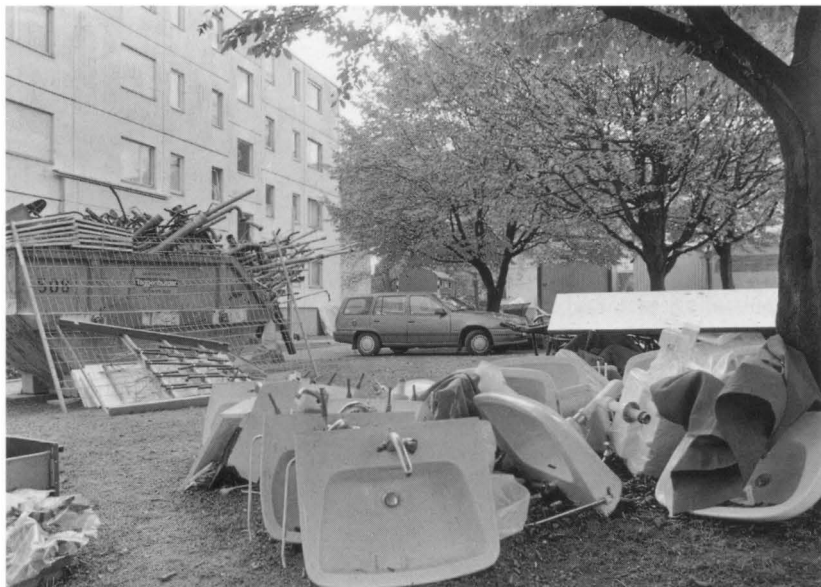
264 Lavabos und kilometerweise Wasser- und Abluftröhren sind ersetzt worden.
