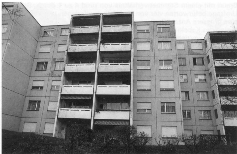
In mehreren Etappen und mit Millionenaufwand wird die Siedlung «Sunnebüel» saniert. Foto: Arthur Phildius
