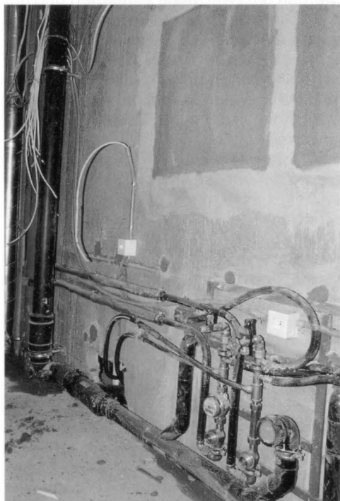
Was sonst hinter der Küchenkombination verborgen bleibt: Die gesamte Sanitärinstallation wurde ersetzt. Ganz links das neue Abluftrohr. Fotos: Arthur Phildius
