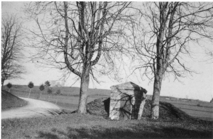
Das Wasserreservoir im Cheiberiet von 1889, kurz vor dessen Abbruch bei der Entstehung des neuen Wohnquartiers Sunnebüel. Links erkennen wir die Strasse nach Kindhausen, rechts hinten die neue landwirtschaftliche Siedlung im Mattenhof des Hegnauer Förster Albert Spillmann (erbaut von Familie Oesch).
