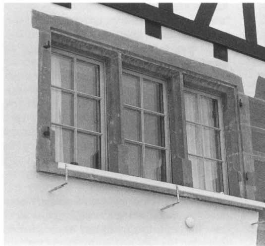
Fensterreihe mit spätgotischen Sandsteineinfassungen.
