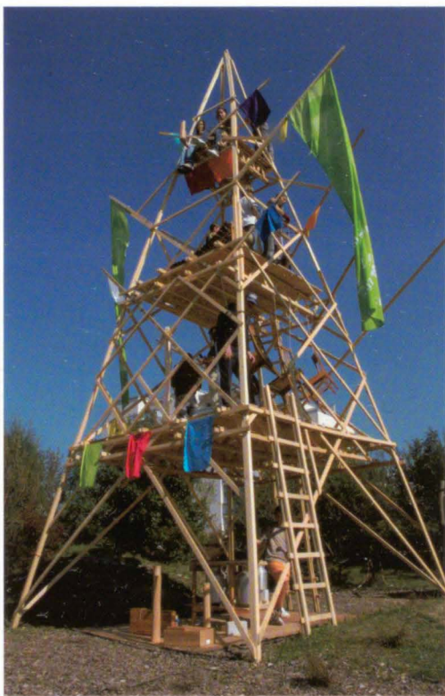
Filigrane Konstruktion aus astfreien Dachlatten: Dank kluger Statik trägt dieser Turm am Volksschuljubiläum ein ganzes Orchester. Im Sommer wird der Turm zusammengebaut. (Bild: Arthur Phildius)
