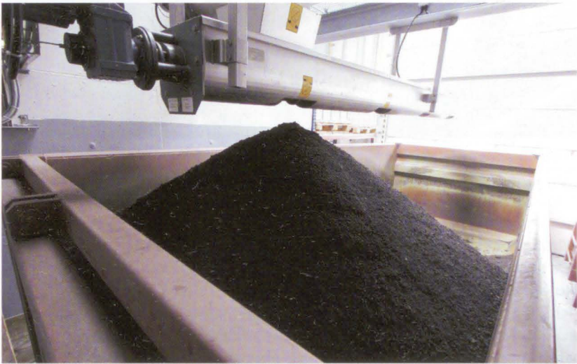
Das Gold der Bachwis: Der Klärschlamm liefert 80 Prozent der Energie, die die Kläranlage jährlich benötigt. (Bild: Walter von Arburg)
