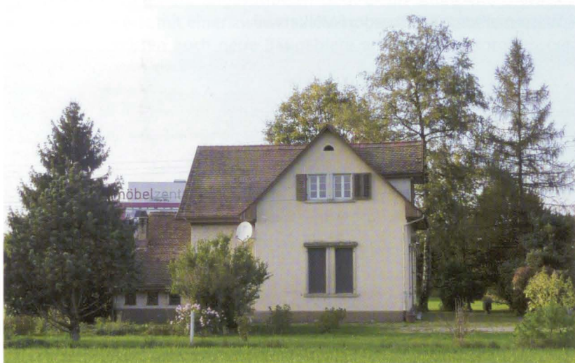
In diesem Pumphäuschen an der Warokreuzung Industriestrasse / Zürichstrasse fördert der Zweckverband GOG Wasser. (Bild: Esther Wolff)
