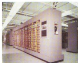
Der grösste je gebaute Röhrencomputer von SAGE wog 275 Tonnen und war mit 55'000 Röhren bestückt.
