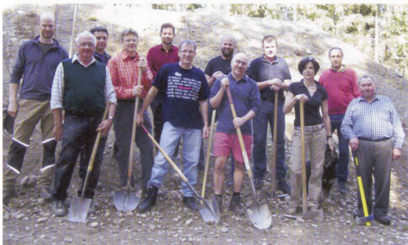
Die Werkkommission greift zu Spaten und Schaufel und bepflanzt den Umschwung des Reservoirs Chellerholz. (Bild: Toni Spitale)
