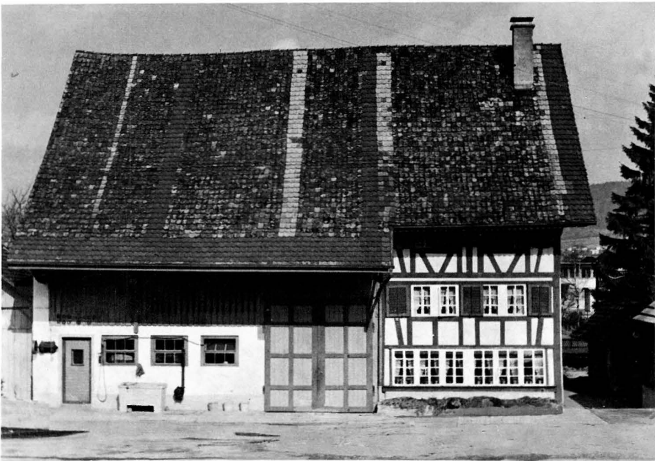
Bauernhaus Alfred Wetters Erben, genannt Haus zur Höll, Badenerstrasse 18 Erbaut um 1600
