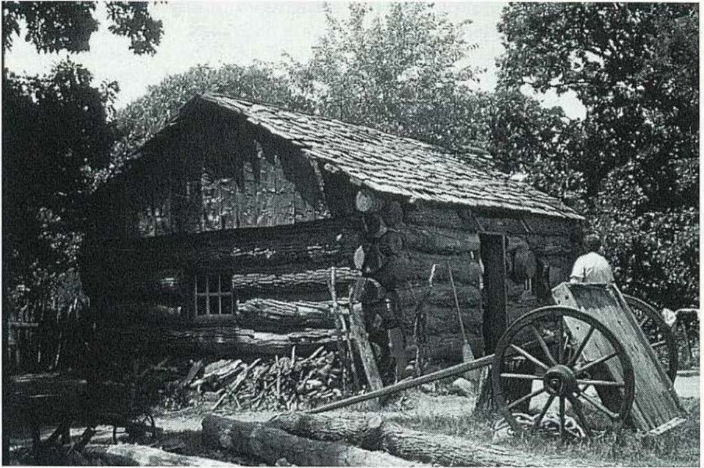
In den ersten Jahren ihres Siedler-Daseins diente den bäuerlichen Einwanderern ein Blockhaus aus unbehauenen Stämmen als Heim.
