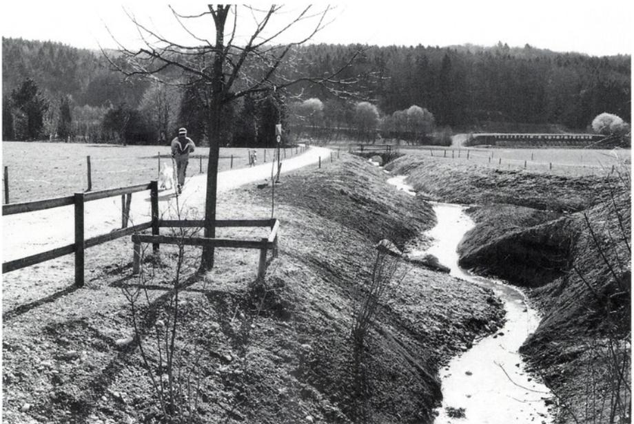
*Der abwechslungsreiche Lauf des neuen Geerenbaches vor dem Durchlass Schützenhausstrasse. Im Gegenlicht und kurz nach Bauvollendung fotografiert, sind die unterschiedlichen Böschungsneigungen und Uferabstufungen gut sichtbar.*
