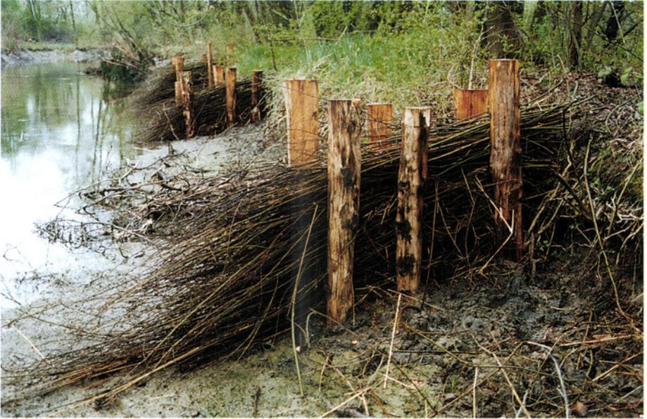
*Faschinenbuhne zur Ablenkung des Stromstriches in die Gewässermittle am rechten Glattkanal-
