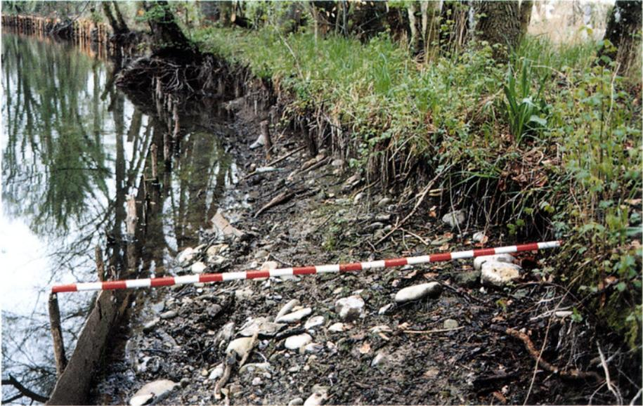
*Massive Erosionen am rechten Glattkanalufer mit der ursprünglichen Längsholzverbauung. Bild vom Frühling 1995 in Richtung Obere Mühle.*
