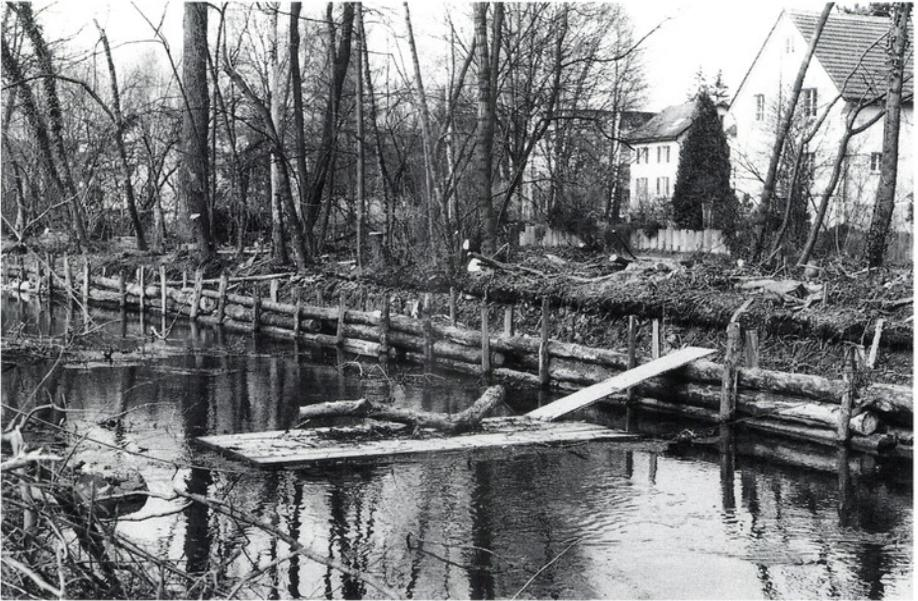
*Im Bau befindliche Rundholzlahnung mit Fischunterständen und der demontierbaren Zufahrt. Die Stege wurden nachts und während andern Arbeitsunterbrüchen entfernt, um auch während der Bauzeit die geschützte Glattinsel von Katzen und Mardern freizuhalten. Rechtes Glattkanalufer, Richtung Obere Mühle.*
