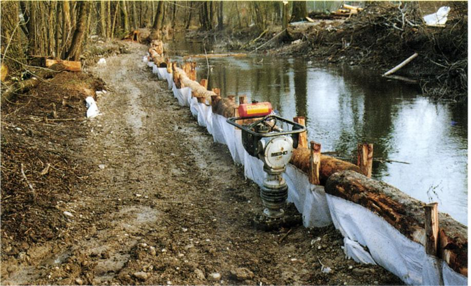
*Rundholzlahnung mit verdichteter Hinterfüllung; das Geotextil verhindert ein Ausschwemmen des Feinmaterials. Frühling 1994, rechtes Glattkanalufer, Richtung Chreis.*
