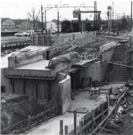
Der vorläufige Bahnhofsausgang Seite Wangenstrasse und die darüber liegende Brücke für Geleise 4 sind bereits zu erkennen.
