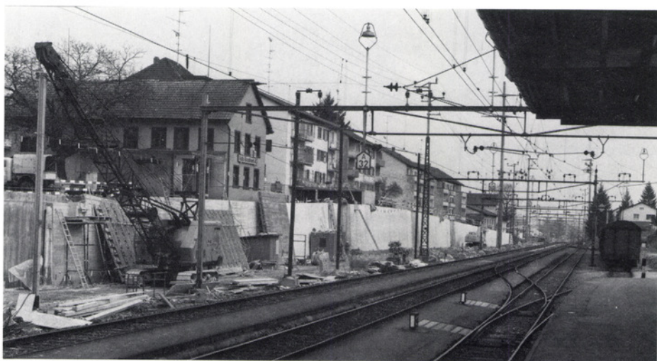
Der Bau einer 350 Meter langen Stützmauer zur Verbreiterung des Bahnhofareals vor den Häusern an der Überlandstrasse benötigte vom Frühjahr 1981 an ein ganzes Jahr.
