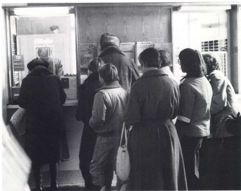
Die Bahnhof-Schalterhalle vor dem Umbau.
