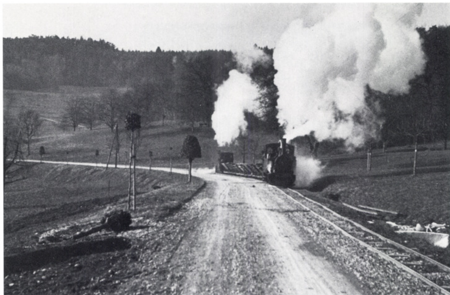
Kiesgewinnung im Rafzerfeld: Der Kies wurde über kilometerlange Strecken mit einer Rollbahn befördert.
