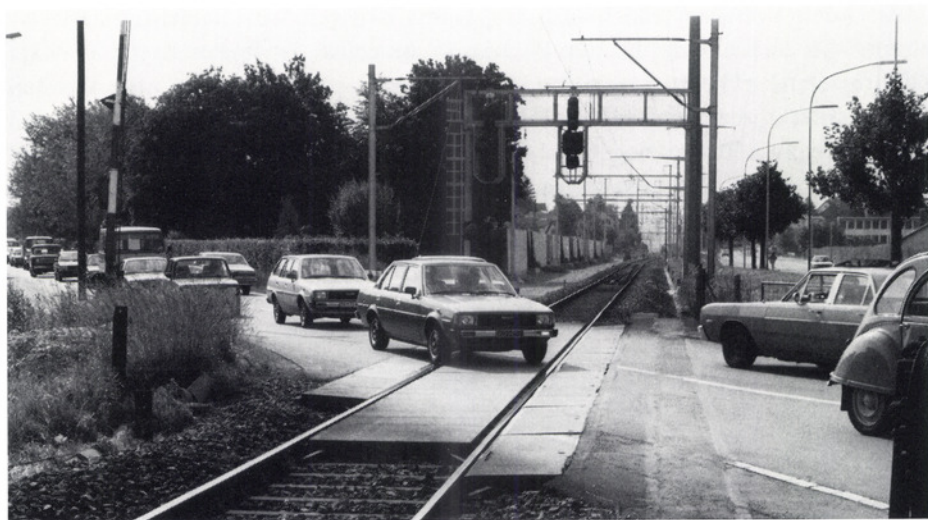
Der einst vielbefahrene, aber seit Ende Juli 1983 aufgehobene Bahnübergang im Schörli konnte aus politischen Gründen nicht rechtzeitig ersetzt werden.
