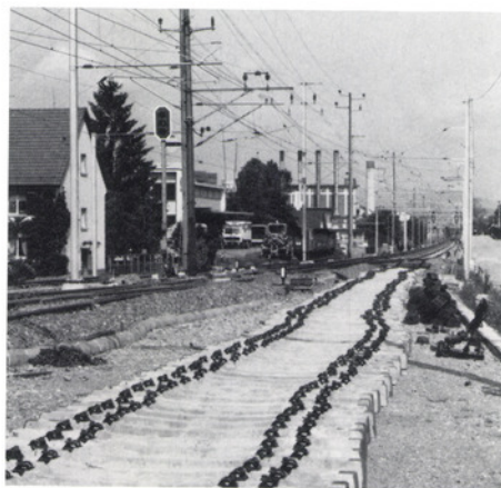
Ausgelegte Schwellen verkünden im Juli 1983 den kurz bevorstehenden definitiven Zusammenschluss des zweiten Streckengeleises von Wallisellen mit dem Bahnhof Dübendorf.
