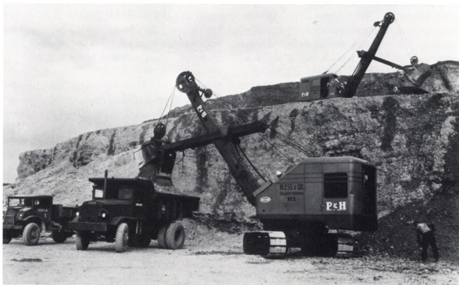
Erste amerikanische Grossgeräte gelangten 1947–1950 beim Bau des Flughafens Zürich-Kloten in Einsatz.
