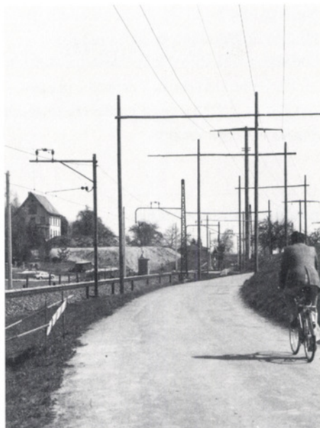
Im Gfenn war bei der Schliessung des Blinklicht-Überganges erst ein aufgeschütteter Erdwall aber noch keine Brücke zu sehen.
