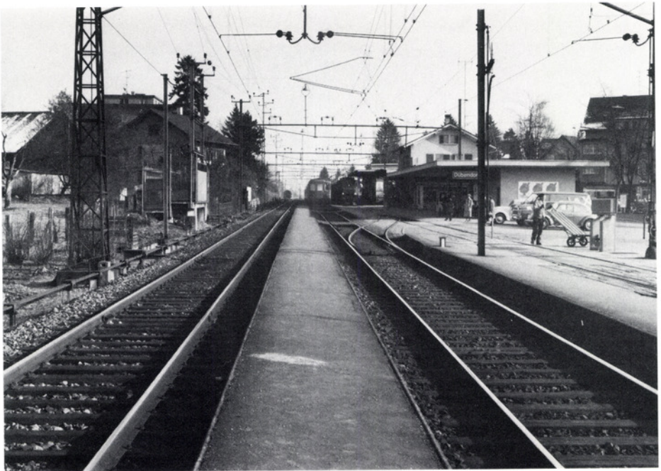
Die Bahnhofanlagen vor Baubeginn im März 1981.
