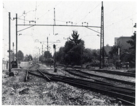
Die alte Fussgänger-Passage Oskar-Biderstrasse beim Umbau der Geleisanlagen.
