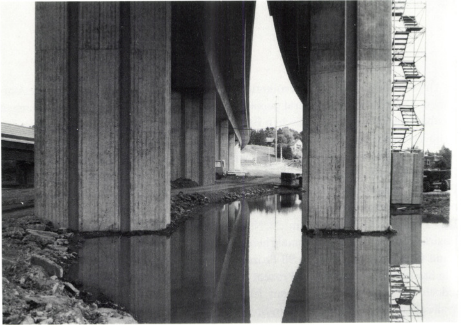
Pfeiler-Landschaft unter dem Neugut-Viadukt. Links der Hauptviadukt, rechts die Auffahr- rampe von Dübendorf her.
