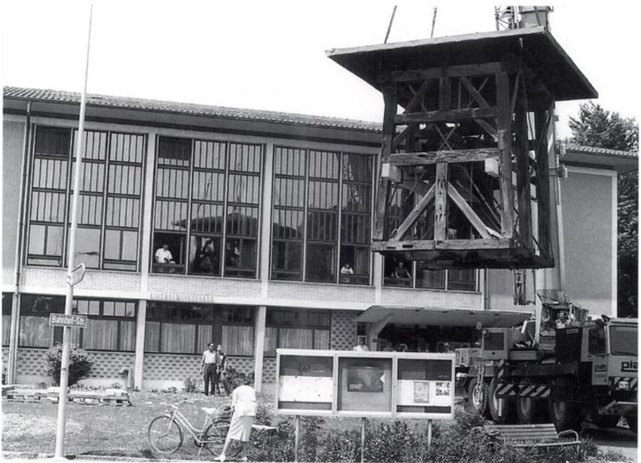
*Mit einem starken Pneukran wurde der Glockenstuhl an den provisorischen Standort verschoben; die langersehnten Bau- und Renovationsarbeiten haben damit offiziell begonnen.*
