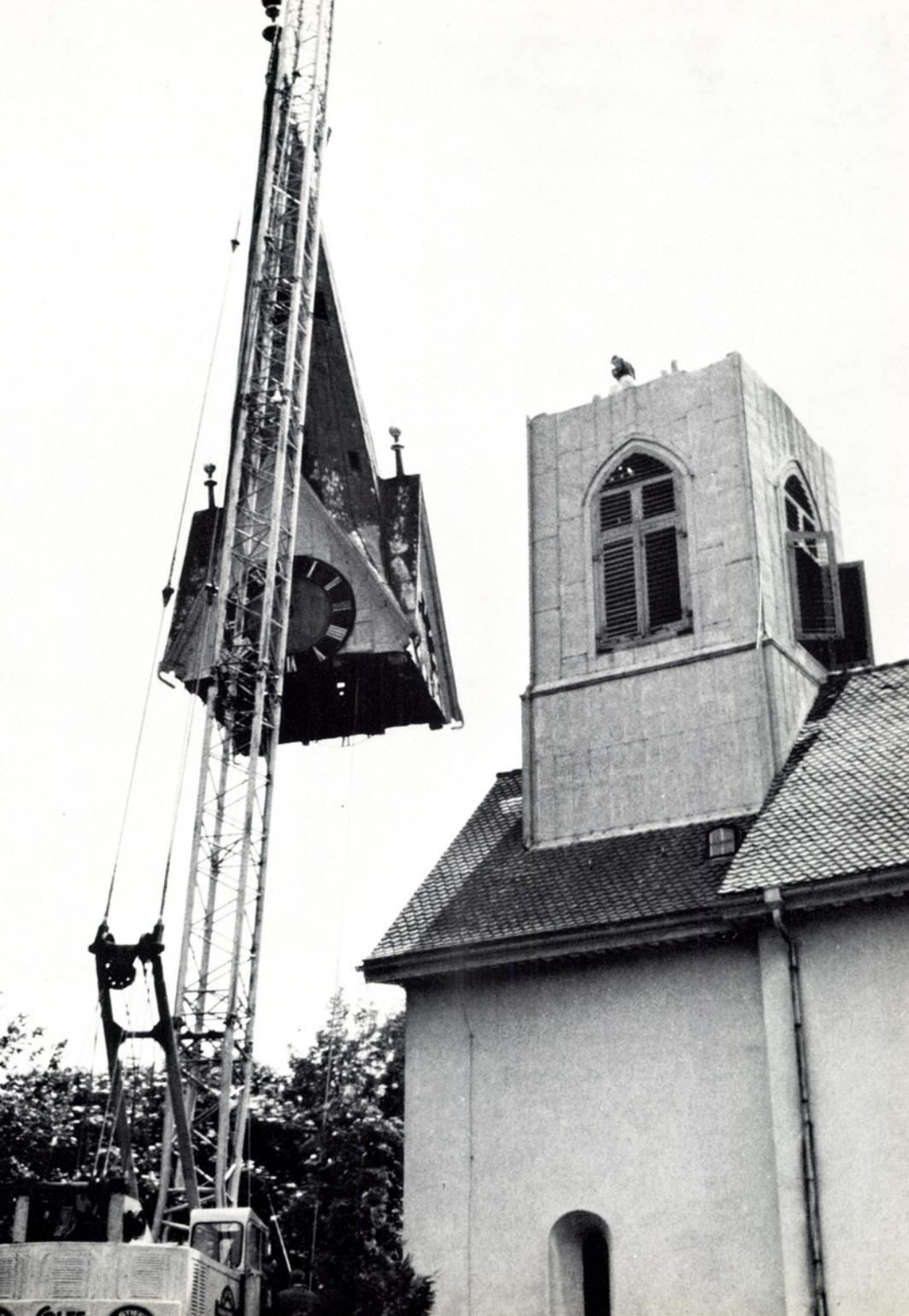
*Nachdem das Stuhlgebälk zusätzlich verstärkt worden war, zog der Spezialkran den vollständigen Glockenstuhl aus der engen Turmverschalung.
