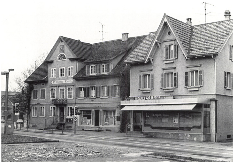
Die Liegenschaft Restaurant Kreuz – seit vielen Generationen architektonischer Schwerpunkt im Städtli – im Februar 1984.
