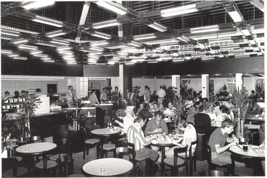
Blick in das neu renovierte und erweiterte Personalrestaurant.
