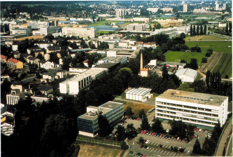
Die heutigen Gebäude der Givaudan: die Forschung rechts, die Administration im Vordergrund und die Produktion im Hintergrund.
