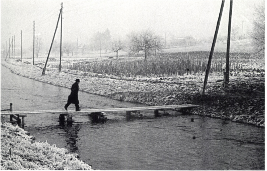
Dieser provisorische Steg über die Glatt musste jeden Spätherbst neu erstellt werden. Er diente als Hauptzugang zum Eisfeld im Chreis.
