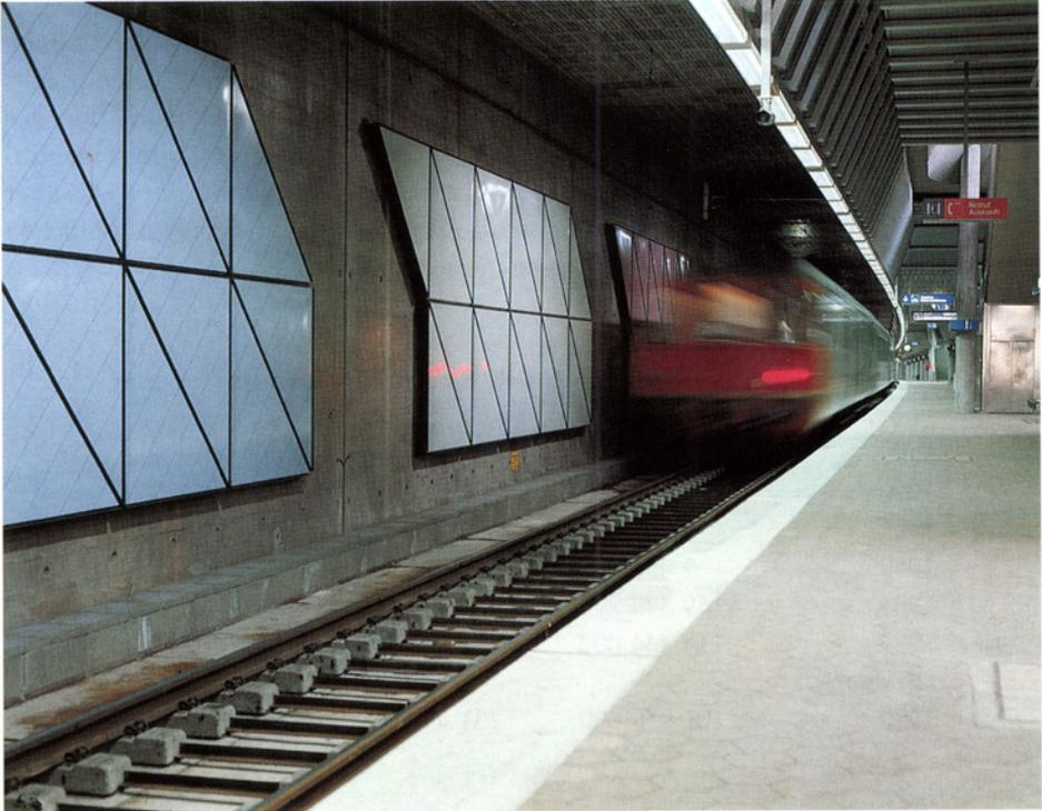
*Die 840 emaillierten Platten weisen eine Gesamtfläche von 1360 Quadratmetern auf. Die Konstruktion muss den durch die Züge verursachten, schlagartig wechselnden Luftdruckbelastungen standhalten.*
